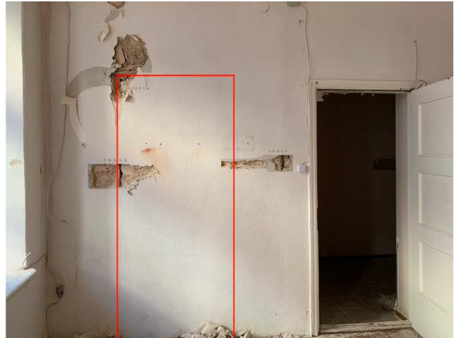
Foto 140-141. Sondaažidega avatud ukseavad põhja- (vasakul) ja lõunaseinas (paremal)
