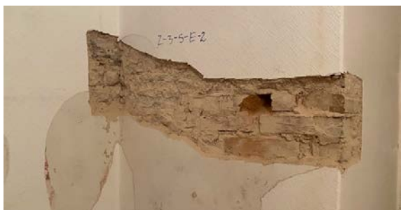
Foto 218. SONDAAŽ 2-3-S-E-2 – krovisondaaž ruumi kagunurgas ja idaseinas. Idasein (fassaad) on laotud punasest tellisest vastu varasemat paekivimüüri.
