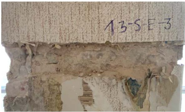
Foto 84. SONDAAŽ 1-3-S-E-3 krohvisondaaž idaseinas, põhjapoolse ja keskmise akna vahel, mis näitab, et müüritises puuduvad märgid akende ümberehitusest. Otse müüritisel paikneb 1843.aasta krohvikihht.
