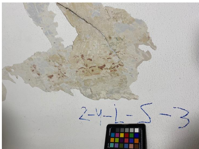
Foto 228. SONDAAZ 2-4-L-S-3 Laesondaaž, kus tuvastati 1843. aasta krohvil trafarett-ornament. Värvitoonid:
