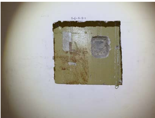
Foto 114. SONDAAZ 1-6-S-S-1 asub ruumi lõunaseina idapoolse osa keskel. Sein on laotud paekivist ning krohvitud lubikrohviga. Krohvil on neli kihti värvi – valge, helesinine ja tuhm roosa liimvärv ning oliivikarva alküüdvärv.
