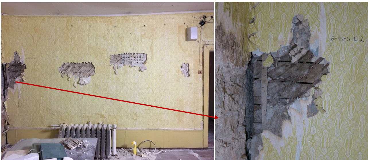
Foto 303-304. SONDAAZ 2-15-S-E-2 – Idaseina põhjapoolne serv ja seina keskosa. Avangutest on näha pajuviitste ja laastumati kasutust krohvi nakkepinnana. Pajuviitstel on kohati säilinud 1843. aasta krohv, mille peal on sinine lubi-/ liimvärv, ajaleht ja üks tapeedikiht.
