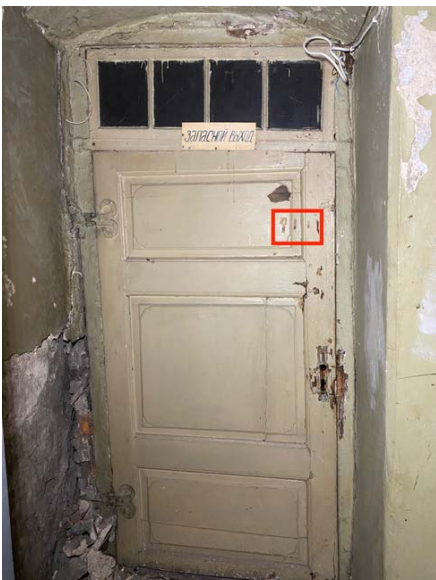
Foto 318. SONDAAŽ U 2-4 Sondaaž asub ukse ülemisel osal. Sondaažid teostati ka ukse teisel poolel. Värvide säilivus ja paljandumine olid erinevates kohtades väga erinev, kuid mitme kontrollsondaažiga õnnestus sellest uksest ühtne pilt saavutada. Täpsem kihtide kirjeldus sondaažikaardil U 2-4 . Samuti on eraldi märkimisväärsed uksele olevad sepietatud oinasarvhinged.
