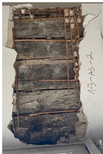
Foto 94-97. Aknasillusteks on „taaskasutatud“ varasemaid baroksete akantusmaalingutega talasid. Ühelgi sondeeritud sillusel küll maalinguid ei tuvastatud, kuid heleda taustavärv fragmentid näitavad, et talad pärinevad varasematest maalitud lagedes.
