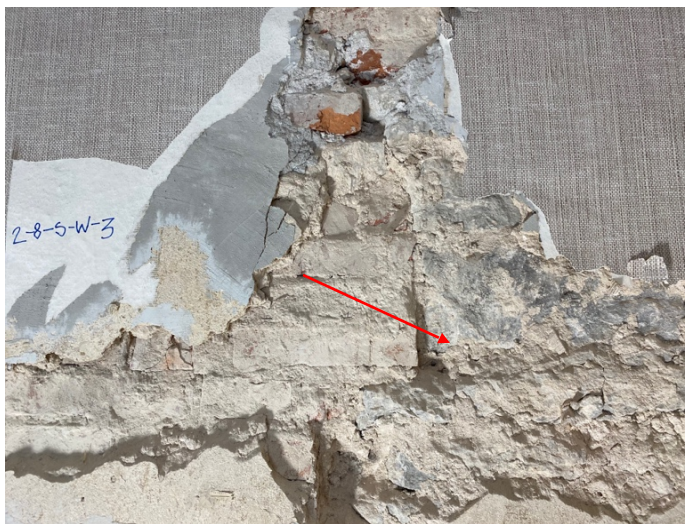
Foto 256. Ruumi lääneseina loodenurgas on säilinud tõenäoliselt 1843. aasta ümberehituse eelne paekivist siseseina jupp.
