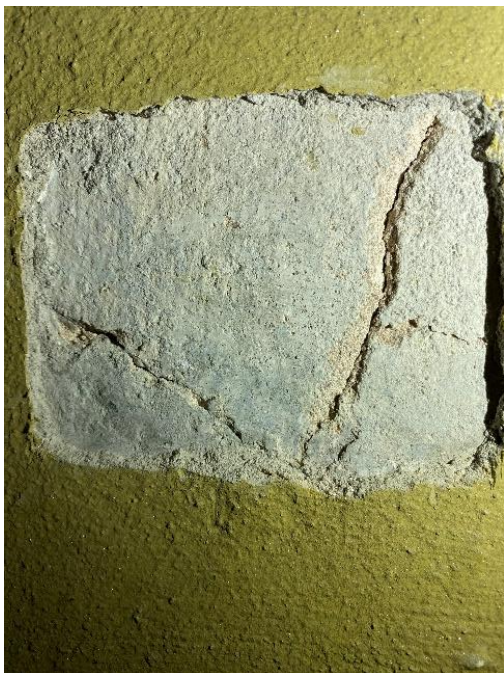
Foto 423. SONDAAŽ F-2 . Silluse imitatsioonide vahelisel alal in originaalpind ülekrohvitud tsemendisislaudsega krohviga. Originaalpinnal on vaid lubivalge, täiendavaid viimistluskihte ei leitud.
