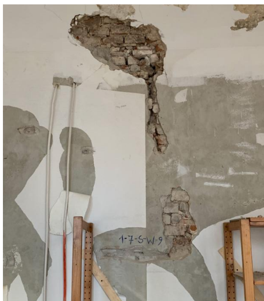
Foto 135. SONDAAZ 1-7-S-W-9 – krohvisondaaž ruumi lääneseinas. Arvestades sellega, et kuni 1900. aasta ümberehituseni paiknes käesolevas ruumis hoone teine peauks, peaks ehitusloogikast lähtudes ka ruumi lääneseinas olema mingisugune läbipääs. Sondaažiga avatud alalt ei tulnud välja uksepilluseid ega teisi seal paiknenud avale viitavaid elemente, kuid oleks soovitatav seina suuremas mahus avada, et selgitada välja, kas selles seal on paiknenud avatäide või mitte. Sondaažilt loetav vaid tellistest müüriladu, ehkki selle konarlik iseloom viitab millegi kinnimüürimisele.
