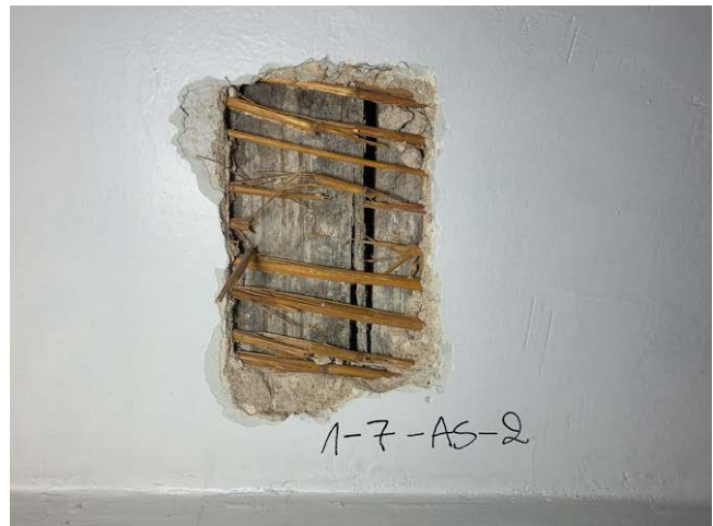
Foto 138-139. Kõrvutatud SONDAAZ 1-7-AS-1 ja SONDAAZ 1-7-AS-2 – krohvisondaažid ruumi aknasillustel näitavad, et aknasilluste lahendus ühtib ülejäänud hoone aknasillustega. Kuigi taladel ei ole tuvastatud maalinguid, viitavad ehitusmaterjalid siiski 1843. aasta ümberehitusele ja varasemate ehitusjärgkude materjali taaskasutusele.
