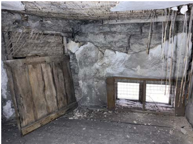
Foto 52-53. Fotod vahekorrusest ja lähivaade lae krohvist ning krohviarmeeringust.
