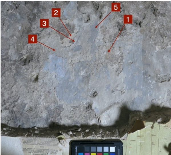
Foto 102-103. Lubi- ja liimvärvi kihid põhjaseina vanemal krohvikihil.
