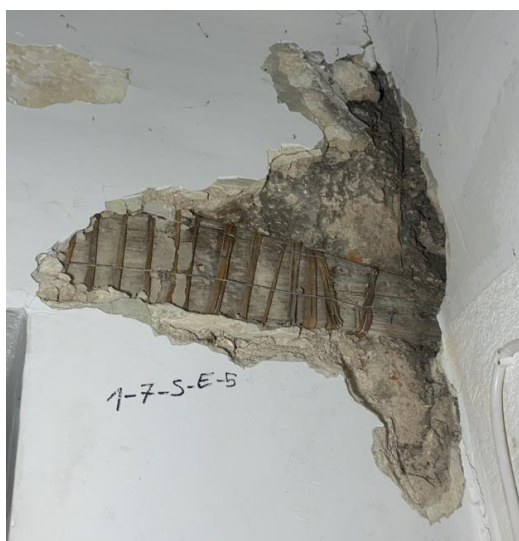
Foto 131. SONDAAŽ 1-7-S-E-5 krohvisondaaž idaseina lõunapoolses nurgas. Krohvikihit all näha akna silluse puidust osa, mis on kaetud traadiga kinnitatud rooga ning mis ulatub kuni ruumi lõunaaseinani välja. Silluse viimistlus ühtib nii käesolevas ruumis kui ka teistes ruumides avatud aknasillustega ja peegelvõlvidega ning on seega seotav 1843. aasta ümberehitusega, mil sellel asukohal paiknes hoone teine peauks.
