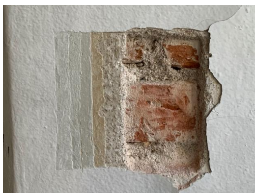
Foto 130. SONDAAŽ 1-7-S-E-4 viimistluskihtide ja krohvi sondaaž lõunapoolse akna aknapaalel. Konstruktsioon on laotud tellistest, mida katab üks krohvikihit millel omakorda on tuvastatud 5 värvikihti. Krohv seostub oletatavasti 1900. aasta ümberehitusega.
