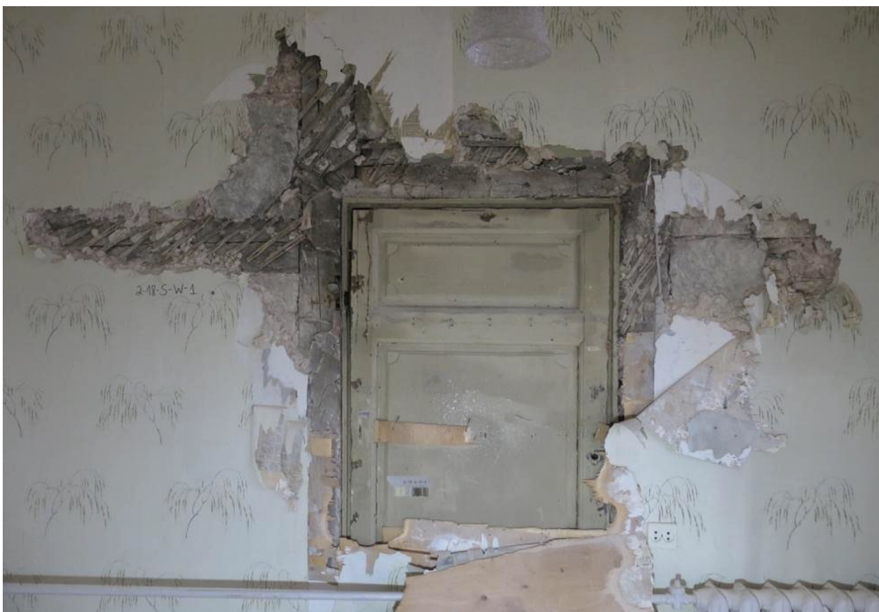
Foto 321. SONDAAŽ 2-18-S-W-1 – Lääneseina keskosas. Paekivist vahvarkseinal on 1843. aasta krohv, mille peal on tsementpahtel ja tapeet. Vineerplaadi alt avanes ukseava – uks on taaskasutus, kuna ülemine serv on lõigatud parajaks. Ukse viimistluskihtidele on koostatud sondažikaart numbriga U 2-5, mis on lisas.
