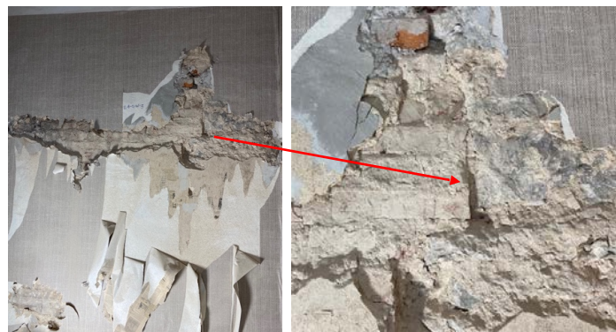
Foto 243-244. SONDAAŽ 2-8-S-W-3 – lääne-seina horisontaalselt läbiv krohvi-sondaaž, mis näitab, et vanemat paekivimüüritist on jätkatud hiljem (ilmselt 1843) tellisega. Seinal on ainult 1843. aasta krohv.
