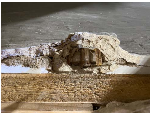
FOTO 65. SONDAAŽ 1-1-US-1 asub põhjapoolse välisukse sillusel ning näha on roomatti ning vana lauda ehk samasugust tüüpi lahendust nagu taaskasutatud baroksete taladega sillustel. Tulevikus tuleks seda sillust suuremalt avada kuna siit võib leida ka maalinguid.
