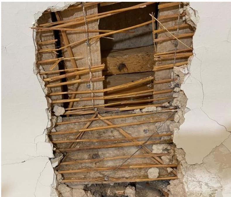
Foto 88. SONDAAZ 1-3-L/PV-N-7 krohvisondaaž põhjaseina peegelvõlvi ja laes. Pееgelvõlvi ja lae konstruktsiooni moodustavad sepanaelttega kinnitatd lauad, millele on traadiga punutud roomatt. Otse konstruktsioonil on 1843.a krohv.
