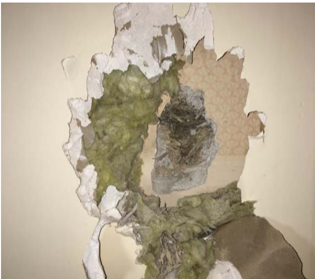
Foto 370. Sondaaž 3-11-S-N-1 – põhjaseina keskosas. Puitsein on kaetud TEP-plaadiga, mille peal on nõukogude-aegne tapeet. Selle peal on soojustus ja kaasaegne kipsplaat.
