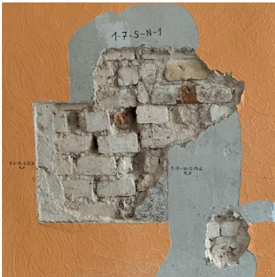
Foto 127. SONDAAŽ 1-7-S-N-1 krohvisondaaž põhjaseinas. Seina müüriladu on tellistest. Osa avatud pinnast on kaetud 1843. aasta krohviga, alumise osa tumedama värvitooniga viimistletud krohv ühtib 1900. aasta ukse asukoha muutmisega seotava krohviga, mida tuvastati ka sondaažil 1-7-S-E-3 .
