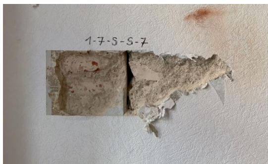
Foto 133. SONDAAZ 1-7-S-S-7 – krohvisondaaž lõunaseinas. Sondaaž paikneb otse sondaaži 1-7-S-S-6 all ning sellel on näha vastava endise ukseava idapoolset uksepalet. Ukseava paled on laotud tellistest ning viimistletud faasitud nurgaga sileda pinnana.
