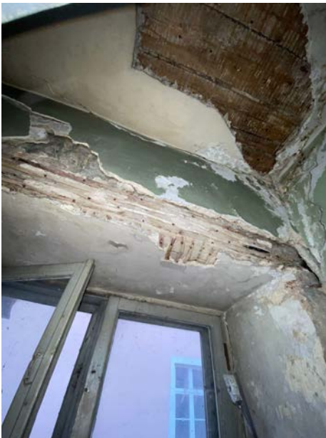
Foto 329. SONDAAZ 2-19-AS-3 asub põhjaseinas asuva akna kohal. Puitsillusel on näha kistud vitsad krohvi armeeringuna.
