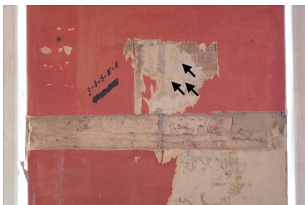
Foto 336. Sondaaž 3-3-S-E-1 ruumi idaseinas, u 1400 mm kõrgusel põrandapinnast. Seinal on üks krohvikihht, kus varaseim säilinud viimistluskiht on fragmentselt säilinud kollakas lubivärv (osutatud mustade nooltega), millele järgnevad 1920. aastate makulatuurikihid (vt 3-2-S-N-1 )
