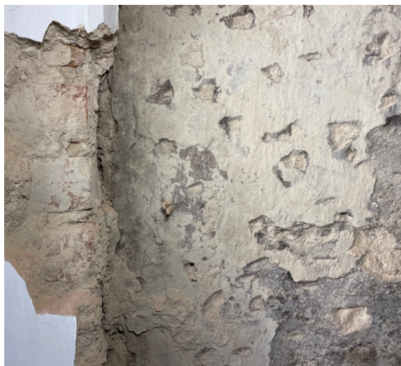
Foto 255. Lõuna ja idaseina (fassaadi) kokkusaamise nurk. Selgelt on näha, et viimistletud lõunasein läheb fassaadi taha.
