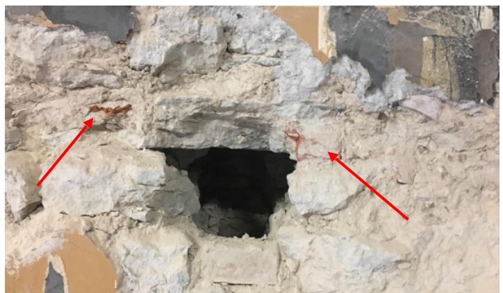
Foto 182. Katusekivi kasutamine krohvi täitematerjalina, mis on iseloomulik 19.saj ümberehitusele.
