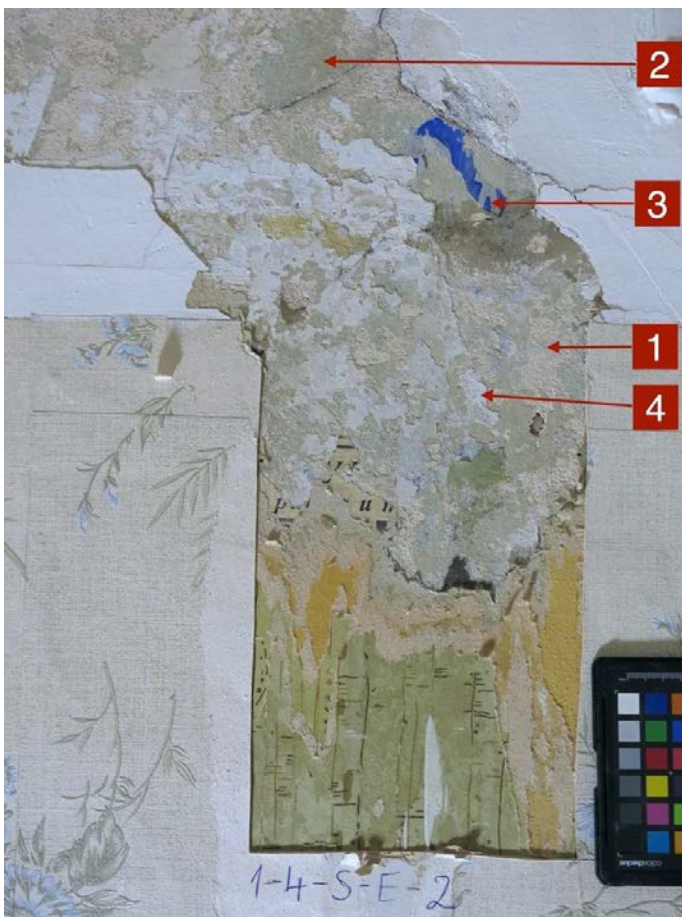
Foto 104. SONDAAZ 1-4-S-E-2 – idaseina ülemine osa. 1843. aasta krohvil on näha fragmentselt säilinud rohekat ja teisi lubi-/liimvärvi kihte (4 kihti: 1. hele kruntvärv; 2. roheline; 3. sinine trafarett hallil taustal; 4. valge). Kolmanda kihi sinine trafarettmuster ulatub peegelvõlvini – sinise värvi fragmente on näha peeglvõlvi all. Sama kiht on suurema pinnana olemas ka ruumis nr 1-2 – vt sondaaz nr 1-2-S-E-3 ). Värvikihtide peal on ajaleht, 6 kihti nõukogudeaegseid ja 1 hilisem tapeet. Tapeetide ülemise ääre piir on põrandast 288 cm.
