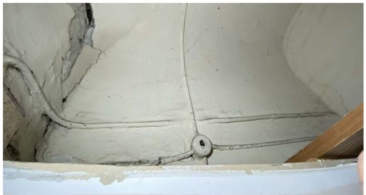
Foto 115-116. SONDAAZ 1-6-L-2 asub ruumi idapoolses otsas ning näitab peegelvõlvidega lage, mis on idas poolitatud vaheseinaga.
