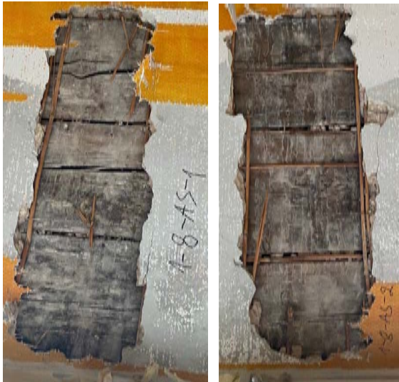
Foto 155-156. Aknasillused 1-8-AS-1 ja 1-8-AS-2 Ruumi kummagi aknasillusel paljandub sarnane varasemate talade taaskasutus, kuid kas need on ka maalingutega kaetud, uuriungute käigus tehtud avangute põhjal ei selgunud. Teostatud sondaaži-akendes maalinguid ei paista.
