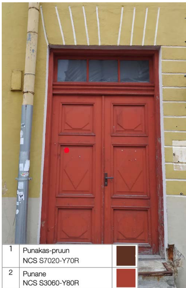
Foto 121. SONDAAŽ VU-5-1 asub välisukse välisküljel, keskmise tahvli nurgal. Sondaažiga on tuvastatud kaks värvikihti, punakas-pruun ja punane (lähemalt vt sondaažikaardilt VU-5-1 ).
