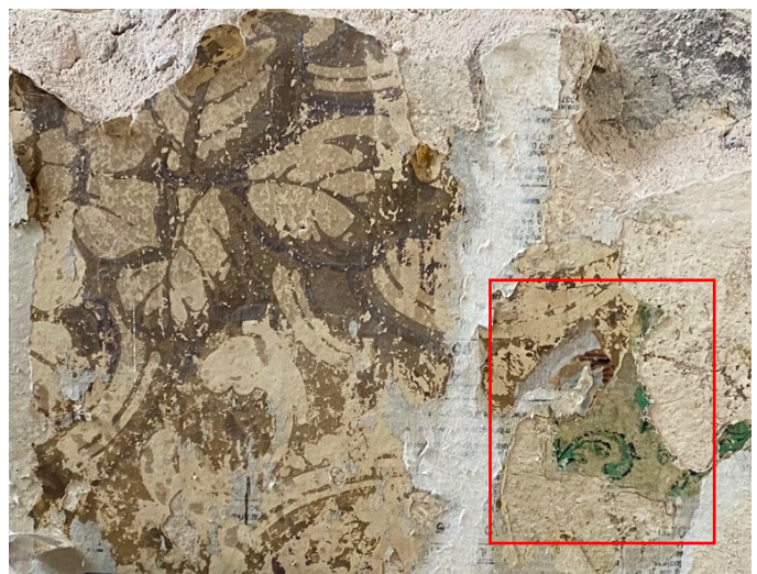
Foto 258-259. Vasakpoolsel fotol roheline arseenipigmentiga trükitud tapeet ning parempoolsel pruun lehemustriga tapeet. Fotol näha ka nende ajaline järgnevus (vt punase kastiga markeeritud piirkonda).
