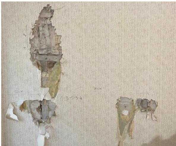
Foto 85. SONDAAŽ 1-3-S-S-4 krohvisondaaž lõunaseinas, mis näitab varasema ukse ja ukse silluse asukohta. Ukseleng on aknapale siseservast ca 50 cm kaugusel ning on 143 cm lai. Lõunaseinas on ainult 1843.a ümberehituse järgne krohv, varasemaid kihte ei tuvastatud.
