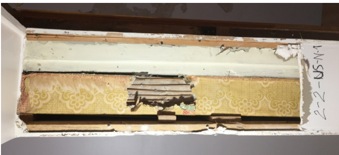
Foto 210. SONDAAŽ 2-2-US-N-1 – Krohvi-sondaaž põhjapoolsel uksesillusel, kus on näha vana (taaskasutatud?) tala ning roomatti.
