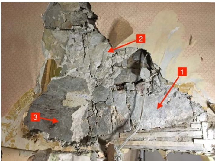
Foto 367. Sondaž 3-10-S-E-1 – idaseina ukse kohal. Tellisseinal on esimeses kihis õhuke lubikrohvi kiht, mis on tõenäoliselt 1843. aasta ümberehituste järgne ning selle peal tuvastati veel kaks erinevat ja märksa hilisemat krohvi, mille peal on nõukogude-aegsed tapeedid.
