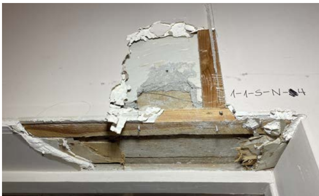
Foto 60. SONDAAZ 1-1-S-N-4 asub ruumi 1-2 viiva ukse kohal. Tegemist ei ole ajaloolise avaga, kuna sellel puudub ajalooline sillus.
