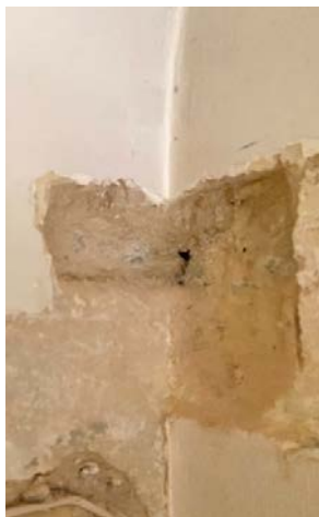
Foto 151-152. SONDAAŽ 1-8-S-W-6 sondaaž ruumi loodenurgas. Põhjalõuna suunaline kaar ja selle ühildumine seinaga. Mõlemad seinad paekivist, kaare peal on kasutatud krohvi sees täitena katusekive, mis viitab 1843.aasta krohvile. Sondaažist tuleneb, et kaar ja sein on samaaegsed. Märkimisväärseid viimistluskihte ei leitud.
