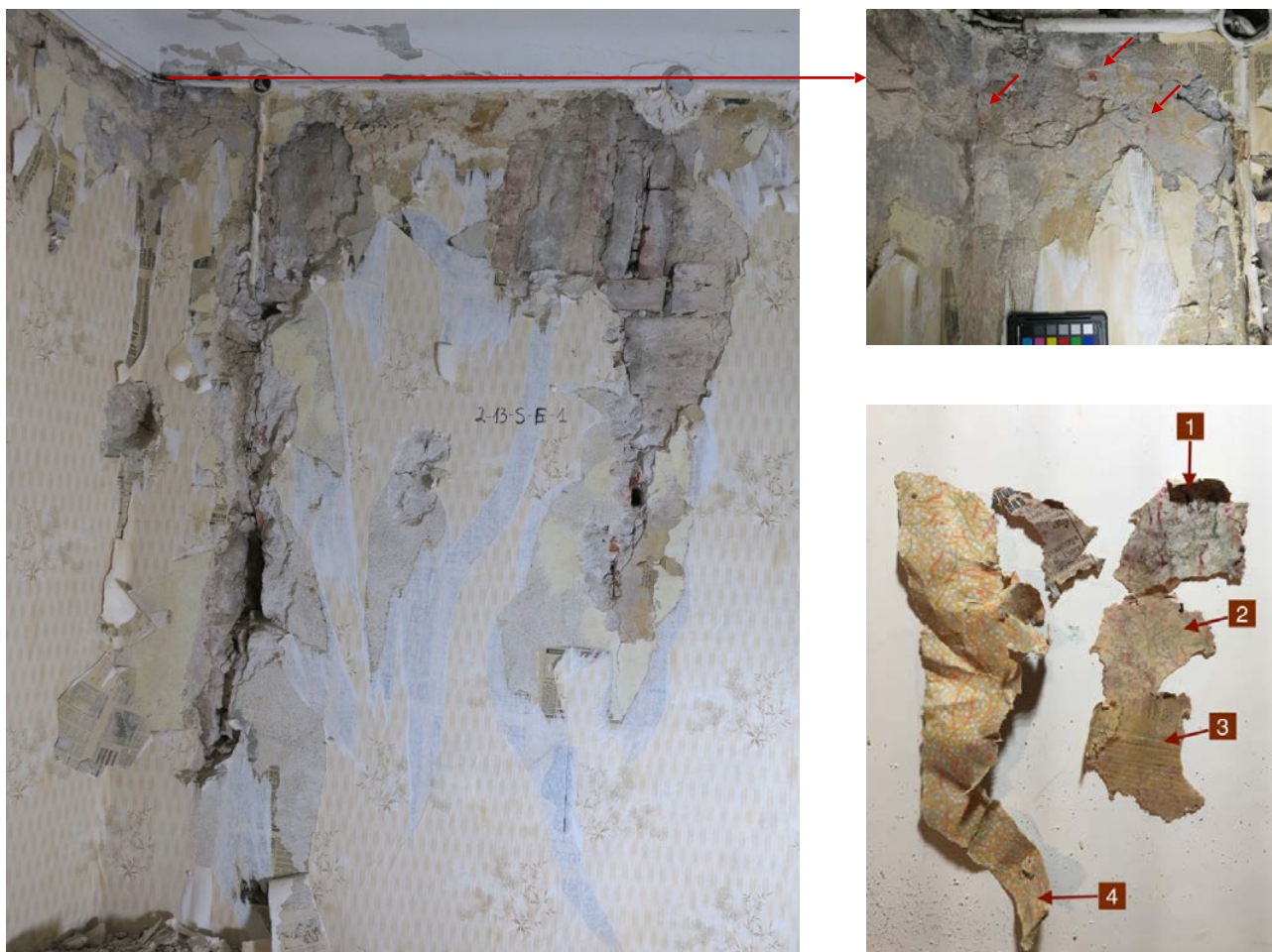
Foto 287-289. SONDAAŽ 2-13-S-E-1 – Idaseina sondaž paljastab tellise ja paekiviga vaheldumisi laotud ukseisilluse, mis viitab 1843. aasta ümberehitustöödele. Ava on suletud suhteliselt hilja, sest uksepalet (kinnimüritud osa ja vana seina vahelt) leiti venekeelset ajalehte ja nõukoguge-aegseid tapeete (4 kihti). Kinnimüürimise krohv on väga sarnane hilisemale mördile, mis on laastumati peal ning mida on kasutatud ruumi 2-11 vaheseinte krohvimiseks (vt foto 290). Idaseina kattev nn 1843. aasta
