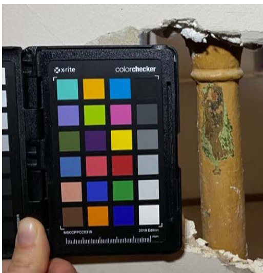
Foto 38. SONDAAŽ A-TREPP-2 asub esimesel korrusel trepi idapoolsel balustraadil. Sondeerides tuvastati viis värvikihti (vaata täpsemalt sondaažikaardilt A-TREPP-2 ).
