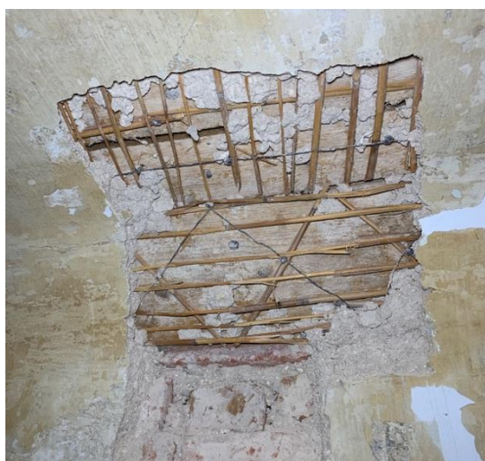
Foto 136. SONDAAZ 1-7-PV-N-10 – krohvisondaaž põhjaseina peegelvõlvi. Võlvi konstruktsiooniks on sepanaeltega kinnitatud lauad ning traadiga kinnitatud roomatt. Otse konstruktsioonil on 1843. aastaga seostuv krohvikihiti. Peegelvõlvi konstruktsioon jätkub ka laes (Sondaaž 1-7-L-N-11 ), mis kinnitab, et lagi ja peegelvõlv pärinevad samast ehitusjärgust.
