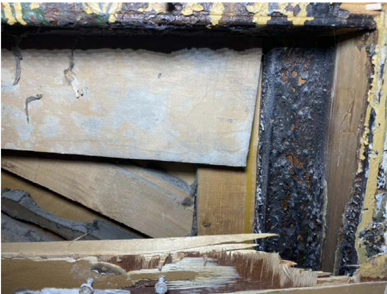
Foto 43-44. II. ja III. korrusel põlenud trepiire.
