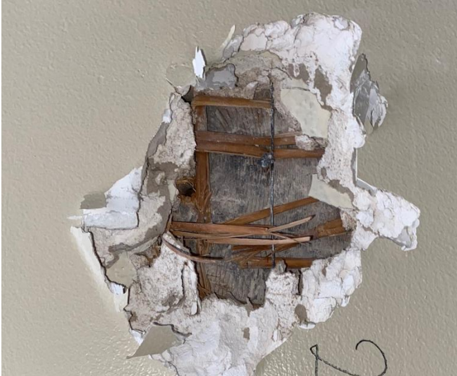
Foto 213. Aknasillus 2-2-AS-1 . Ka selle ruumi aknasillusel on näha talade taaskasutust, kuid sondaažiavast pole selge, kas neil on ka maalingud.
