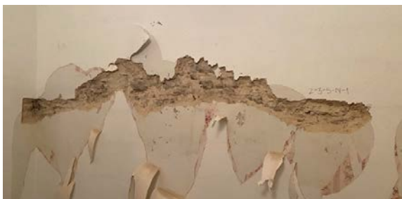
Foto 217. SONDAAŽ 2-3-S-N-1 – krovisondaaž põhjaseinas (hoone välissein). Sondaažiga tuvastati, et müüriladu on paekivist, kuid 1843. aasta eelne krovh puudub ning vahesein, mis eraldab ruume 2-3 ja 2-4 ei ole seotud põhjaseinaga.
