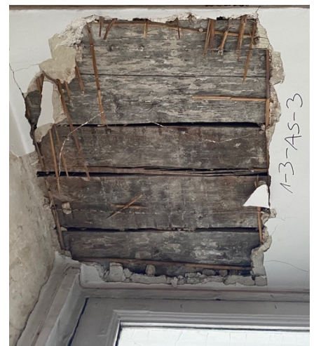
Foto 94-97. Aknasillusteks on „taaskasutatud“ varasemaid baroksete akantusmaalingutega talasid. Ühelgi sondeeritud sillusel küll maalinguid ei tuvastatud, kuid heleda taustavärv fragmentid näitavad, et talad pärinevad varasematest maalitud lagedes.
