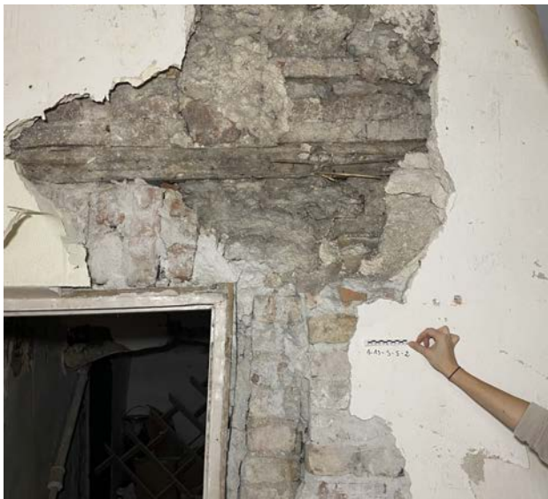
Foto 195. SONDAAZ 1-13-S-S-2 asub ruumi lõunaseina keskel. Lubikrohvi alt paljandub mitmes etapis muudetud sein, mis koosneb paekivist ja telliskividest. Samuti on seinas näha varasema ava puitsillust, see ava on hiljem väiksemaks müüritud.
