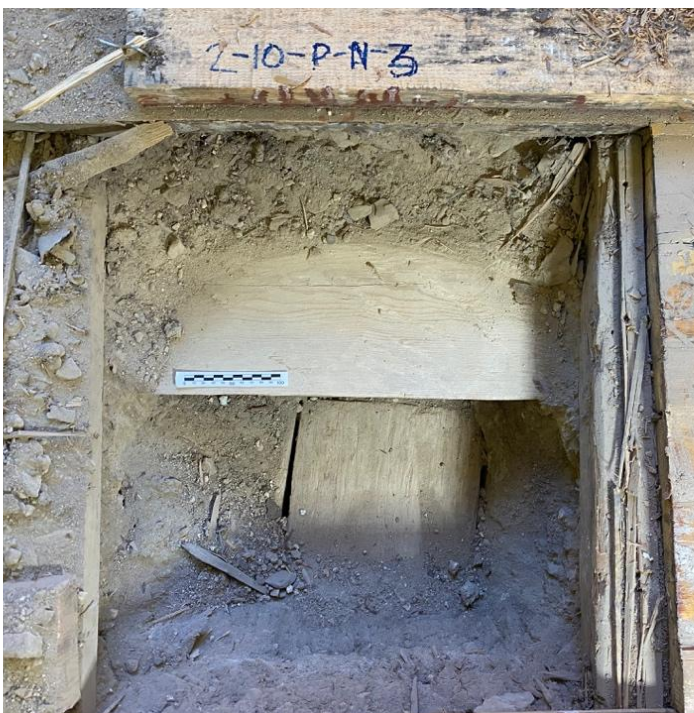
Foto 266. SONDAAZ 2-10-P-N-3 põranda-sondaaz, kus tala on maalinguteta ning tugevate töötlusjälgedega.
