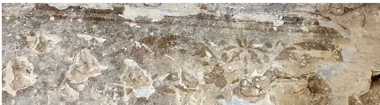
FOTO 93. 1843.a ümberehituse eelne viimistluskiht trafarettmaalinguga seinakarniisitsoonis.
