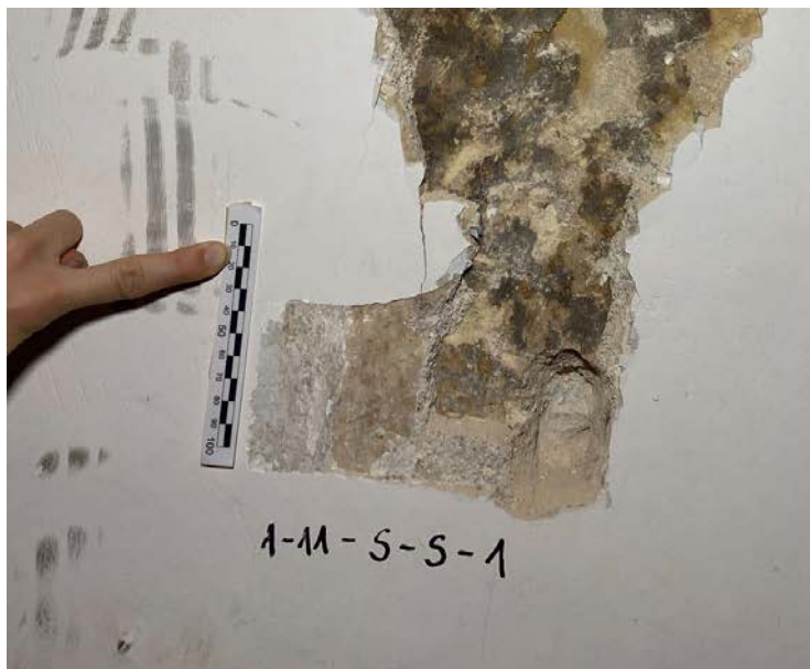
Foto 184. SONDAAŽ 1-11-S-S-1 – seina-sondaaž ruumi lõunapoolses osas hoone välisseinas. Sein on laotud paekivist ning seda on kaks korda krohvitud.
