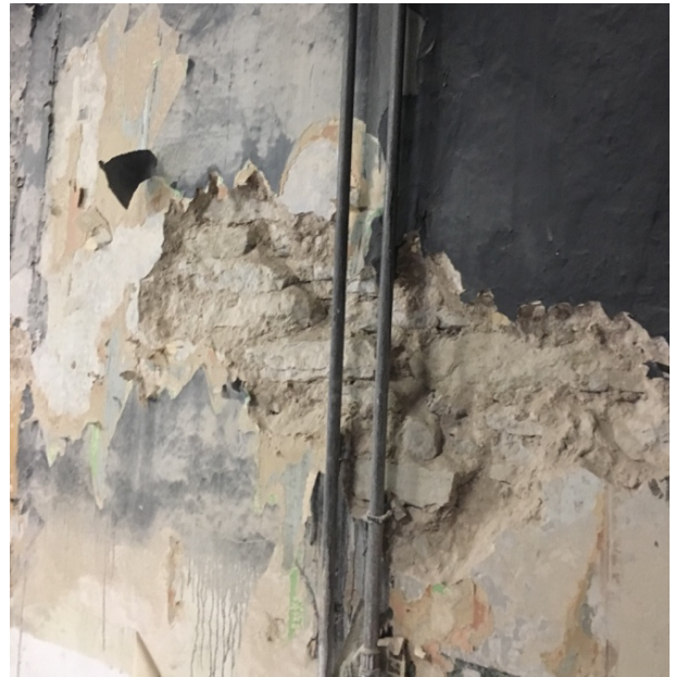
Foto 32-33. Näited suure saali (1-10) kivilaost. Vasakpoolsel fotol punase ringiga tähistatud näited katusekivide kasutusest seinä tasandamis, mis on iseloomulik ja seotud 1843.a ümberehituskrohviga. Parempoolsel fotol aga seinamüüritise väljavajumine.
