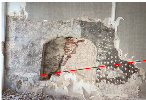
Foto 252-253. Teadmata funktsiooniga krohvi sisse pressitud horisontaalne süvis lõunaseina idaniši kõrval.
