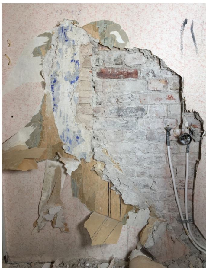
Foto 73-74. SONDAAŽ 1-2-S-E-3 – Sondaaž idaseina keskosas, uksest paremal. Müüritises on näha ka majaplaanile märgitud, kuid nõukogudeaegsete renoveerimistöödega kinni müüritud ukseava (vt ka ruum 1-3). Osaliselt on säilinud 1843. aasta krohv, millel on näha valget kruntvärvi ja selle peal hilisemat tumesinist piiramata pinnana teostatud trafarettmustrit helehallil taustal. Mustri peal on säilinud ca 2 kihti nõukogudeaegset ja 1 kiht hilisemat tapeeti.
