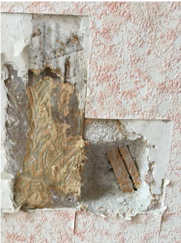
Foto 71. SONDAAŽ 1-2-S-N-1 Sondaaž ruumi põhjaseinal. Laastumatt on krohvitud lubitsement mördiga. Viimistlemiseks on kasutatud korduvalt tapeeti. Suure tõenäosusega on tapeedikihtide arv olnud sama, mis läänesinas (6 kihti sondaaži nr 1-2-S-W-6 järgi), kuid need on vahepeal eemaldatud.
