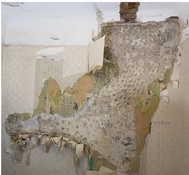
Foto 82. SONDAAŽ 1-3-S-N-1 – põhjasein (hoone välissein), sondaž maast laeni. 1843.aasta renoveerimiskrohvi alt paljandub varasem krohvikihht, millel on ca 7 viimistluskihti. Selle peal on 1843.aasta krohv ning hilised, 20.saj (valdavalt nõukogude perioodi) viimistlused.
