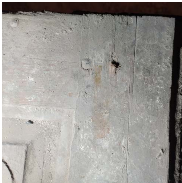
Foto 374. Sepisnaelad, mille abil ukseleht on pööningu toolvärgile naelutatud.
