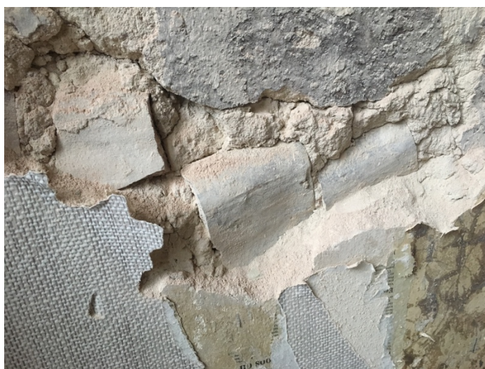
Foto 16-17. 1843. a renoveerimisele on iseloomulik seinapinna tasandamiseks varasemate katusekivide kasutus krohvi sees. Näited ruumidest 2-8 ja 2-3, aga samasugust materjalikasutust võib märgata kõikjal, sh ka B-korpuse ruumides.
