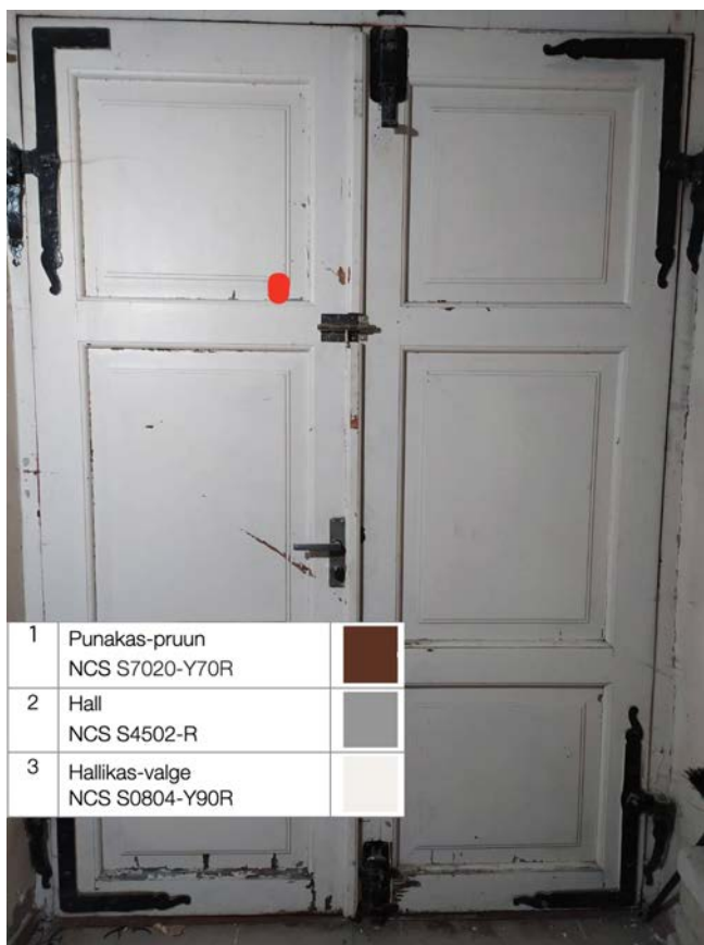
Foto 122. SONDAAŽ VU-5-2 asub välisukse siseküljel, ülemise tahvli nurgal. Sondaažiga on tuvastatud kolm värvikihti, punakas-pruun, hall ja hallikas-valge (lähemalt vt sondaažikaardilt VU-5-2 ).
