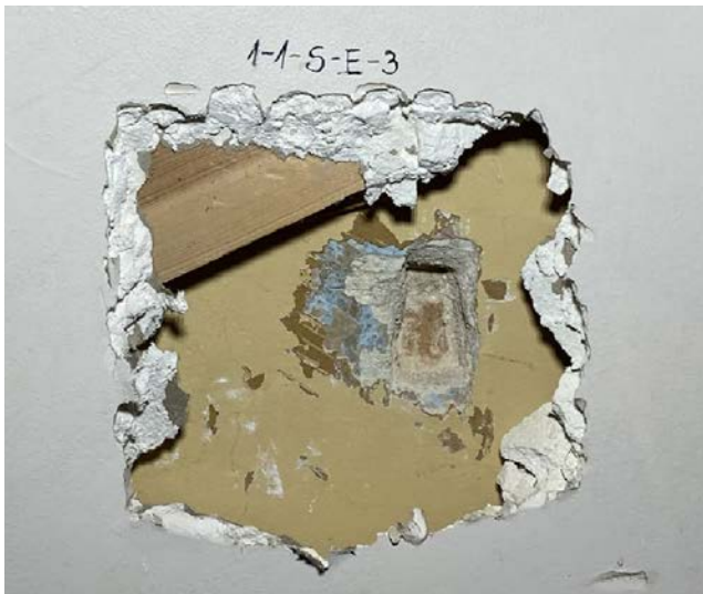
Foto 59. SONDAAZ 1-1-S-E-3 asub trepi juures, ruumi idaseina ülemises osas ning selle kõik kihid kattuvad sondaazi 1-1-S-N-1 kihtidega.
