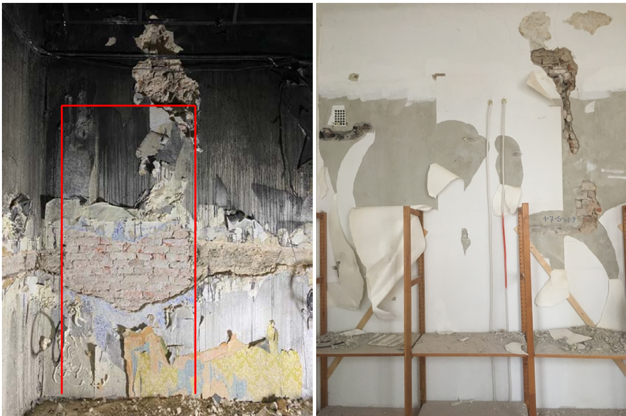
Foto 27-28. Ukseavade asukoht saalis (vasakul) ja ruumis 1-7 (paremal), pildistamise suund on näidatud ka joonisel X siniste nooltega. Saali ukse ligikaudsed piirid on fotol markeeritud punasega. Tegemist oli esindusliku, ligi 3 m kõrge ja 1,5 m laia uksega. Ruumis 1-7 ei ole anfilaadse ava piirid enam loetavad, kuid on selge, et selle seinaga on midagi juhtunud – oletuslikult on see seotud ukseava sulgemisega.
