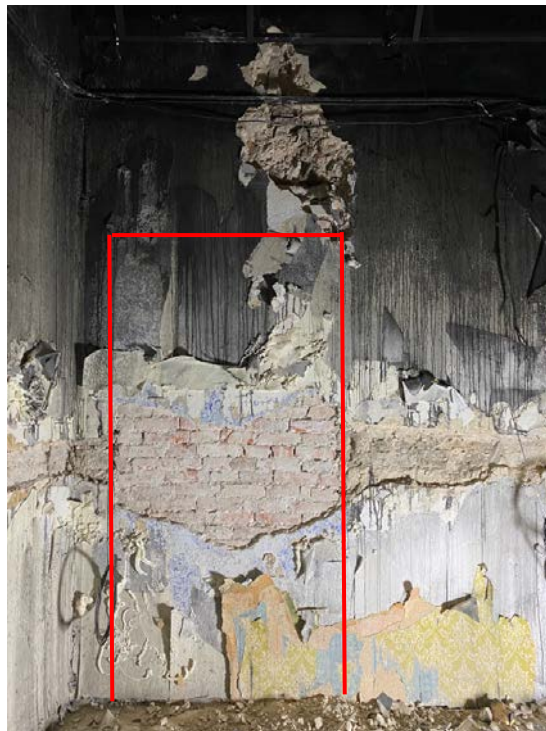
Foto 178. Punasega märgitud varasema ukseava piirid idaseinas. Ukse kõrgus u 280, laius u 130.
