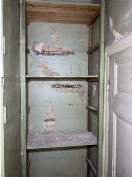
Foto 316. SONDAAŽ 2-17-S-S-3 Sondaaž paikneb ruumi lõunaseinas ehk hoone välisseinas. Näha on kolme maalitud triipu, millest kõrgeim on umbes 190 cm kõrgusel, keskmine 150 cm kõrgusel ning madalaim 107 cm kõrgusel.
