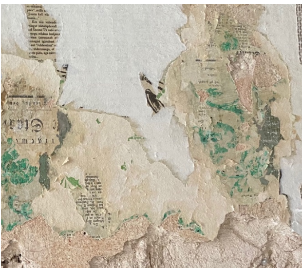
Foto 258-259. Vasakpoolsel fotol roheline arseenipigmentiga trükitud tapeet ning parempoolsel pruun lehemustriga tapeet. Fotol näha ka nende ajaline järgnevus (vt punase kastiga markeeritud piirkonda).
