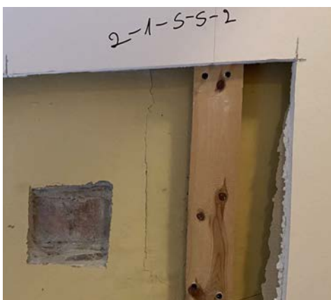
Foto 204. SONDAAŽ 2-1-S-S-2 asub ruumi lõunaseina läänepoolsel osal trepi kohal ning näitab kõrge tsemendisisaldusega krohviga tellisladu.
