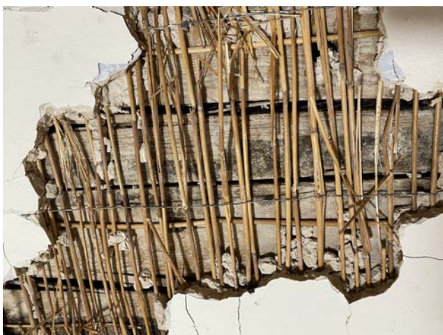
Foto 64. SONDAAŽ 1-1-L-7 asub ruumi trepist ida pool laes, ruumide 2-1 ja 2-2 oleva vaheseina teljel. Puittalad kannavad ülalolevat tellisseina. Krohviarmeeringuna on kasutatud roomatti. Eeldada võib taaskord talade taaskasutust, kusjuures nendel taladel on tahma jälgi, eriti tugevasti just teineteise vastas olevatel külgedel.
