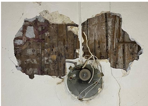
Foto 112. SONDAAŽ 1-5-L-1 Sondaaž lae keskosas. Lagi on kaetud tsementkrohviga ning ka laudis tundub pigem uuem (lauad on pehkinud, sellest nende tume toon), millest annab tunnistust laudise kinnitusnaelte iseloom.
