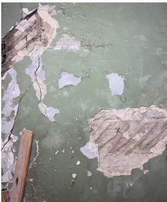
Foto 327. SONDAAŽ 2-19-S-E-1 asub ruumi idaseina põhjapoolses ääres. Näha on puidu ja kivi segakonstruktsiooni, mille puitosadele on naeltega kinnitatud kistud vitsad armeeringuks lubikrohville.
