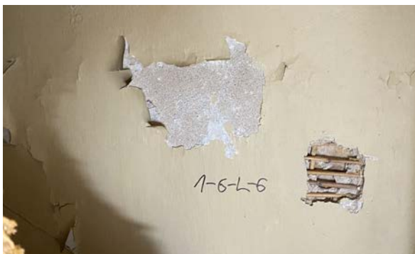
Foto 120. SONDAAZ 1-6-L-6 asub ruumi keskel. 1843. aastaga seostatud krohvi alt tuleb välja roomatt, krohvi peal on kaks kihti valget lubivärvi ning hilisem kollakas liimvärv.
