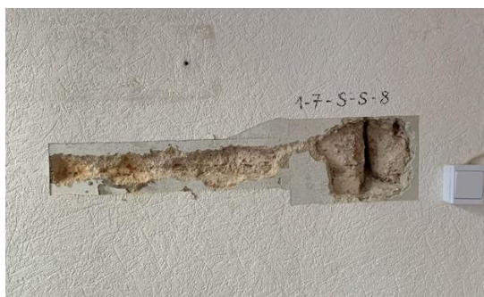
Foto 134. SONDAAZ 1-7-S-S-8 – krohvisondaaž lõunaseinas. Käesoleva sondaažiga on otsitud sondaažilt 1-7-S-S-7 leitud uksepalele analoogset vastet ukse teisel poolel, kuid selles mahus teostatud sondaaž soovitud tulemust välja ei andnud. Välja on võimalik lugeda vaid tellistest müüriladu ning arvatavasti 1900. aastaga seostuvat krohvikihiti.
