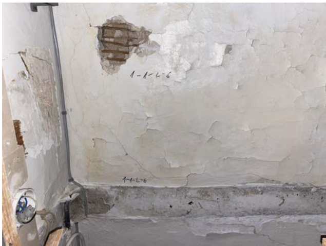
Foto 63. SONDAAŽ 1-1-L-6 asub ruumi 1-2 viiva ukse kohal laes. Roomatil märkimisväärsete viimistluskihtideta laekrohv. Erinevalt teistest tubadest, ka eeldatavatest tuulekodadest välisuste ees, on trepikoja seinad peegelvõlvideta.
