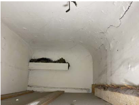
Foto 115-116. SONDAAZ 1-6-L-2 asub ruumi idapoolses otsas ning näitab peegelvõlvidega lage, mis on idas poolitatud vaheseinaga.
