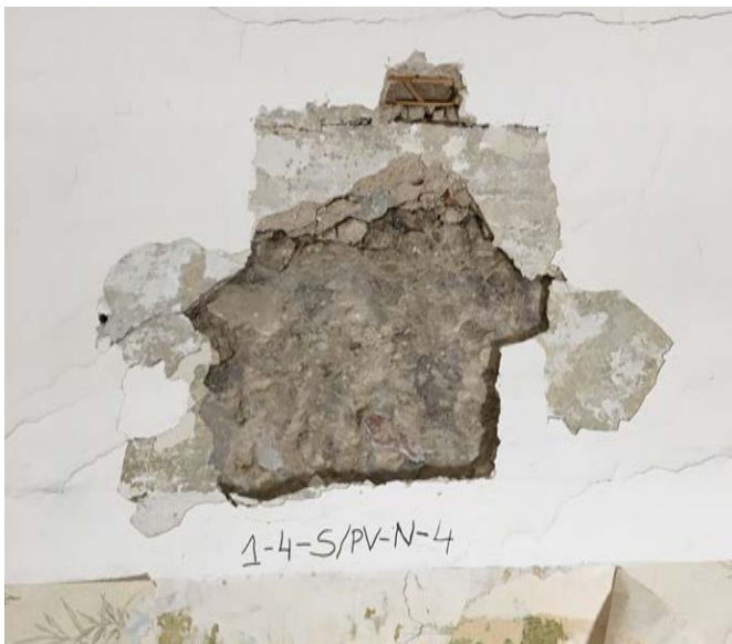
Foto 106. SONDAAŽ 1-4-S/PV-N-4 sondaaž põhjaseina ülemises osas ja peegelvõlvil. Fotol on näha kaks krohvikihiti – 1843. aasta ümberehituse aegne ja varasem, mis ulatub peegelvõlvi laudise ja roomatini.
