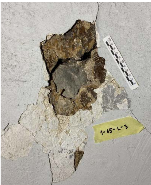
Foto 201. SONDAAŽ 1-15-L-3 Sondaaž paikneb ruumi põhjapoolse osa silindervõlvitud laes.
