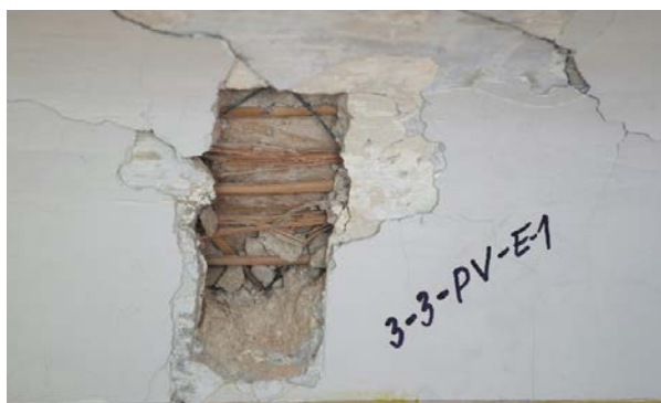
Foto 335. Sondaaž 3-3-PV-E-1 ruumi lääneseina peegelvõlvil. Sondaažiga leidis kinnitust peegelvõlvide üheaegne valmimine kõigil hoone korrustel (krohv, peegelvõlvi alus, sepanaelad ning sidumistraat ja -muster, vrdl ruumiga 1-3).
