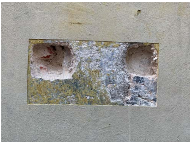
Foto 422. SONDAAŽ F-1 . Fassaadi soklil teostatud sondaaž kinnitab 1-7 ruumi idaseina sondaažilt välja loetavat informatsiooni. Siseruumis nähtav püstvuuk on loetav ka välisseinas ning kinnitab 1-7 ruumi leidude alusel järeldatud 1900. aasta ümberehituse eelset avatäidete lahendust (ukse ja akna asukoha vahetamist, vt rohkem ruum 1-7).
