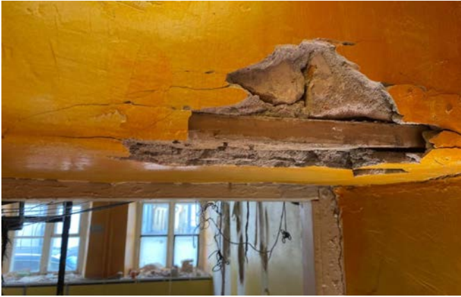
Foto 163. SONDAAZ 1-9-S-E-2 Uksesilluse keskosa. Kogu konstruktsioon näib pärinevat 1843.aastast, millele viitab sillust kattev krohv.
