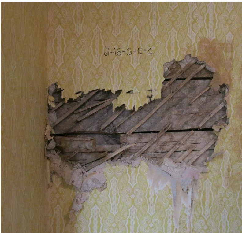
Foto 308. SONDAAŽ 2-16-S-E-1 Tahatud palkides idaseinal on näha taaskord pajuvitstest alusmatti, 1843. aasta lubikrohvi, millel on säilinud heleroosa lubi-/liimvärv, ajaleht ja üks tapeedikiht.
