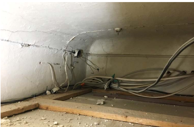
Foto 214. Ripplae taha peitunud peegelvõlviga lagi.
