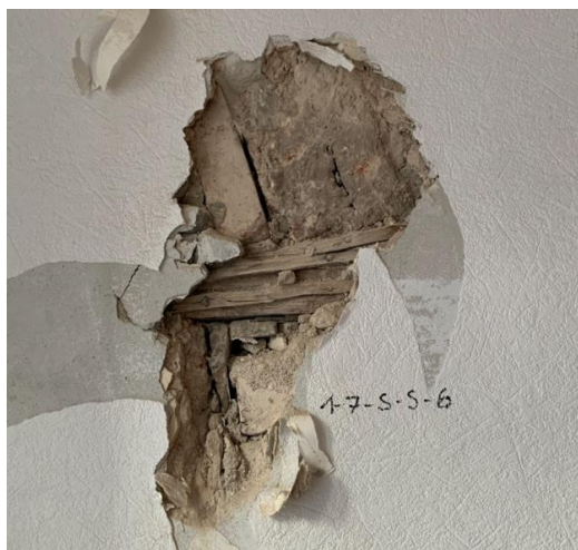
Foto 132. SONDAAŽ 1-7-S-S-6 krohvisondaaž lõunaseinas, mis näitab varasema ukse ja ukse silluse asukohta. Ava paikneb samal, anfilaadi moodustaval teljel põhjaseinas avatud uksega. Uksesillus on laotud tellistest ning tugevdatud puidust talaga. Krohvide vaatlusele ja ehitusloogikale tuginedes on põhjust siduda selle ukse kinniehitamist 1900. aasta ümberehitusega.
