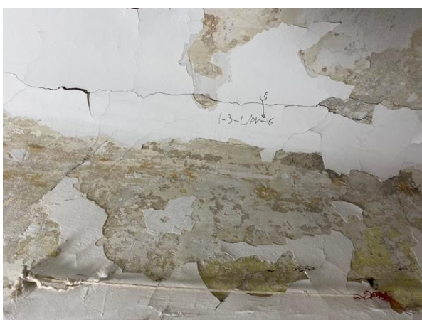
Foto 87. SONDAAŽ 1-3-L/PV-E-6 viimistluskihtide sondaaž peegelvõlvil ja laes. Varaseimal (1843.a järgsel) kihil on aimata polükroomse dekoori jälgi, kuid kihi väga fragmentse säilivuse tõttu on muster loetamatu. Üksikute irdsete fragmentide põhjal näib, et see on teostatud ookertoones.
