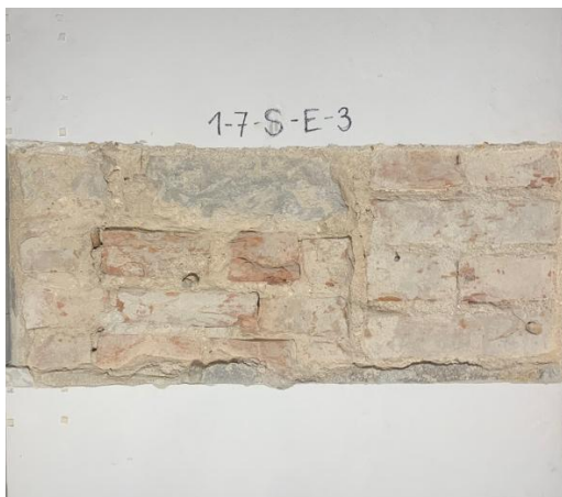
Foto 129. SONDAAŽ 1-7-S-E-3 krohvisondaaž idaseinas, kahe akna vahel. Müüritises välja loetav püstvuuk, mis viitab avatäidete ümberehitusele. Varasemale ehituslahendusele viitab keskmine, paekivist ja tellisest laotud osa millest mõlemale poole on hilisema ehitusjärgu käigus laotud aknapaale. Müüritise peal on suurema teraga krohv, mida on põhjust seostada 1900. aasta fassaadi ümberehitusega ning mis esineb ka teistes ruumi osades. Lõunapoolse akna asukohal paiknes enne 1900. a. ümberehitust ukseava.
