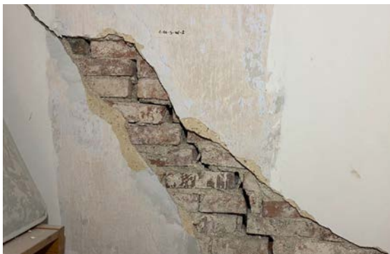
Foto 185. SONDAAZ 1-11-S-W-2 seinasondaaz ruumi lääneseinas. Erinevalt kõrval olevatest seintes on see laotud telliskividest.
