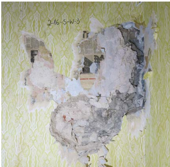
Foto 310-311. SONDAAŽ 2-16-S-W-3 – sondaaž lääneseina paremas servas, keskosas. 1843. aasta krohvil on säilinud valge ja roosa lubi-/liimvärv, ajaleht ja üks kiht tapeeti.
