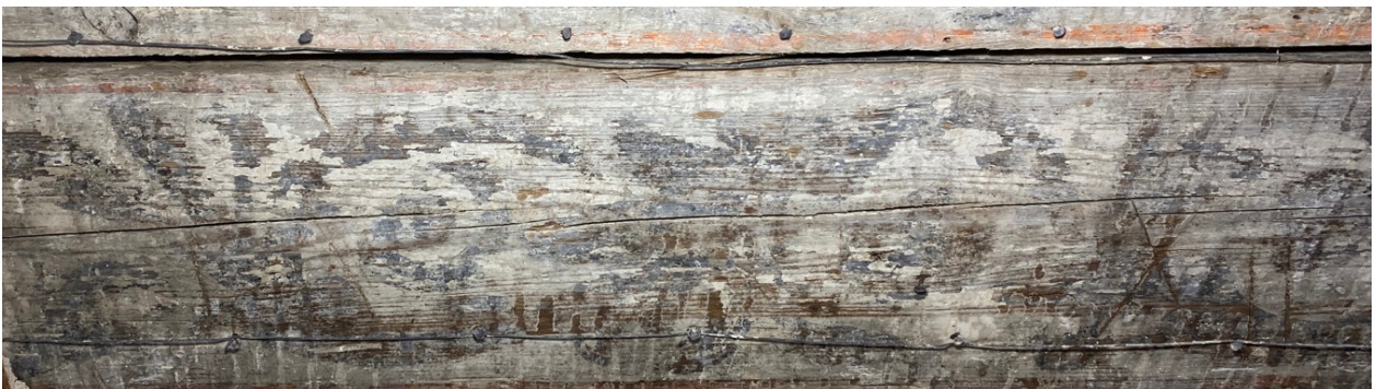
Foto 355-358. Ruumi 3-8 aknasillused, kus on taaskasutatud terve hoone ühed paremini säilinud maalingutega talasid.
