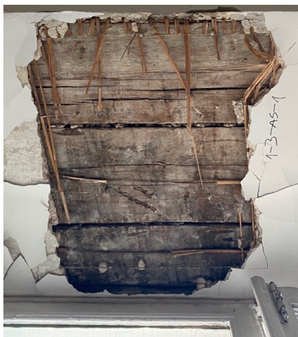
Foto 94-97. Aknasillusteks on „taaskasutatud“ varasemaid baroksete akantusmaalingutega talasid. Ühelgi sondeeritud sillusel küll maalinguid ei tuvastatud, kuid heleda taustavärv fragmentid näitavad, et talad pärinevad varasematest maalitud lagedes.
