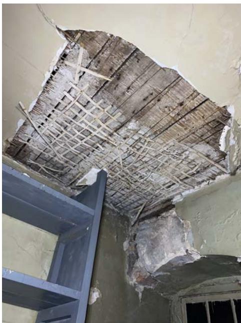
Foto 314. SONDAAŽ 2-17-L-1 Sondaaž asub ruumi loodenurgas laes ning ulatub ukse U 2-4 silluseni. Lael on näha nii roomatti kui ka laastumatti. Uksesillus on laotud paekividest.
