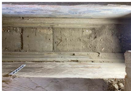
Foto 267-268. Kõrvuti paiknevad põrandatalad, millest üks on maalitud, teine mitte. Suure tööenäosusega on tegemist tala taaskasutusega 19.sajandi ümberehituses.
