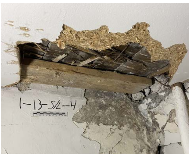
Foto 196-197. SONDAAZ 1-13-S/L-4 asub ruumi lääneseina põhjapoolses nurgas. Laes on näha traadiga kinnitatud roomatti. Ruumi läänesein on laotud tellistest ning krohvitud lubikrohviga, seinal on mõned kihid heledat lubivärvi ning hilisem valge alküüdvärv.
