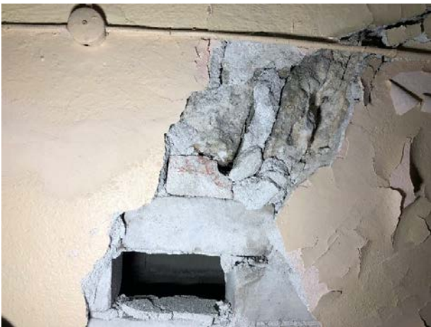
Foto 401-402. Lähivaated põhjaseina kinnimüritud kaarest (vasakul) ja ruumi edelanurgast (paremal)
