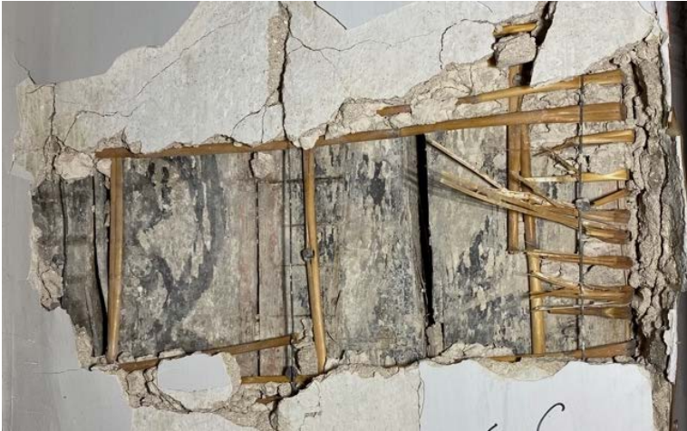
Foto 338-340. Ruumi 3-3 aknasillused alates põhjapoolsest aknast. Vähemalt kahel on säilinud maalingud.
