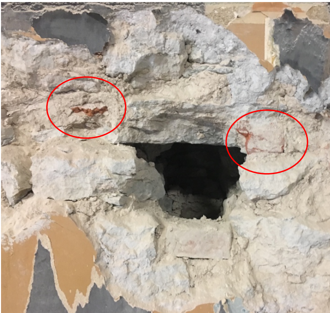
Foto 32-33. Näited suure saali (1-10) kivilaost. Vasakpoolsel fotol punase ringiga tähistatud näited katusekivide kasutusest seinä tasandamis, mis on iseloomulik ja seotud 1843.a ümberehituskrohviga. Parempoolsel fotol aga seinamüüritise väljavajumine.
