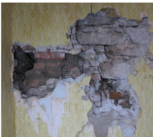
Foto 305. SONDAAZ 2-15-S-W-3 – Lääneseina lõunapoolne serv, seina keskel. Paekivimüüritise kõrval on näha tellistest korstnaosa. Sein on kaetud tsement-krohviparandustega, mille peal on üks tapeedikiht. 1843. aasta krohv on säilinud pigem lääneseina põhjapoolses osas.
