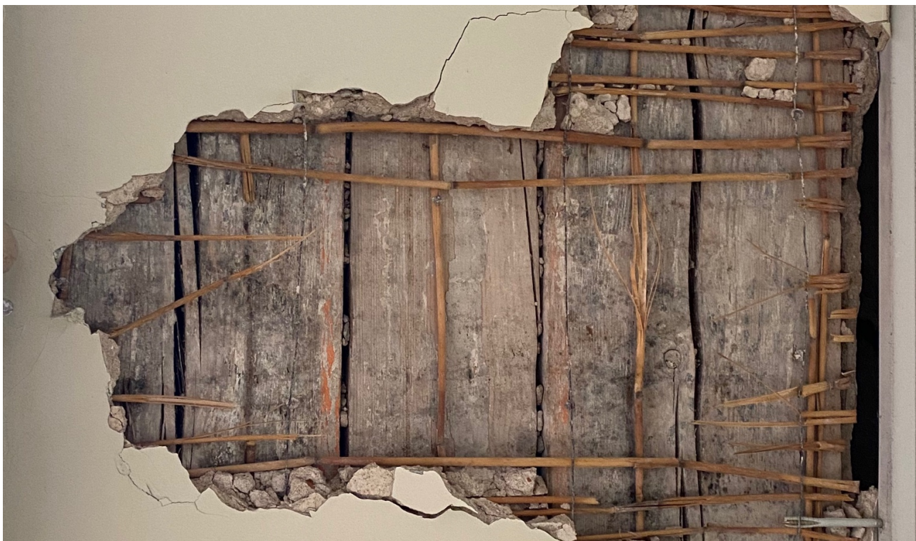
Foto 239. Ruumi nr 2-5 aknasilluse sondaaž, kus on näha barokkmaalingutega talade taaskasutust.
