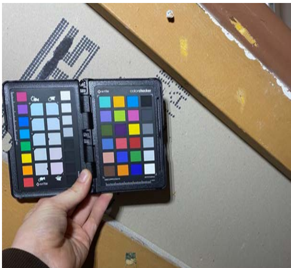
Foto 39. SONDAAZ A-TREPP-3 asub 2. korruselt ülessuunduva trep jooksu läänepoolsel piirdel. Trepilt leiti kaks värvilahendust. Algselt on trepipiire ülaosas olnud kollane ning alaosas tumeroheline, hiljem on trepipiirde n-ö balustraad olnud tumebeež ning käsipuu pruun.
