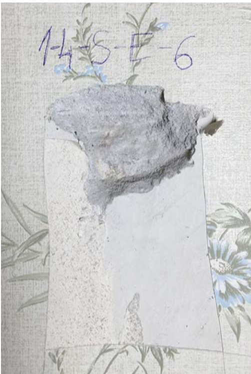
Foto 110. SONDAAZ 1-4-S-E-6 – sondaaz idaseina keskosas. Sein on laotud paekivist. Hilise remondi käigust on tehtud krohviparandusi tsementmördiga.
