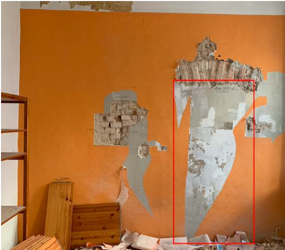
Foto 140-141. Sondaažidega avatud ukseavad põhja- (vasakul) ja lõunaseinas (paremal)
