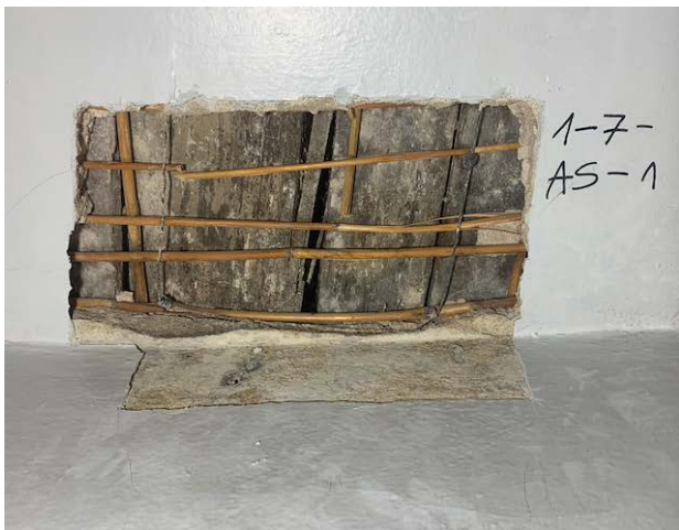
Foto 138-139. Kõrvutatud SONDAAZ 1-7-AS-1 ja SONDAAZ 1-7-AS-2 – krohvisondaažid ruumi aknasillustel näitavad, et aknasilluste lahendus ühtib ülejäänud hoone aknasillustega. Kuigi taladel ei ole tuvastatud maalinguid, viitavad ehitusmaterjalid siiski 1843. aasta ümberehitusele ja varasemate ehitusjärgkude materjali taaskasutusele.
