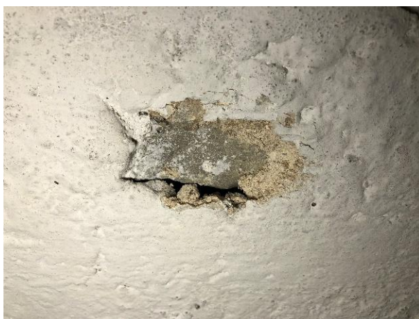
Foto 422. Lähivõte ruumi -2-3 völi krohvisondaažist.
