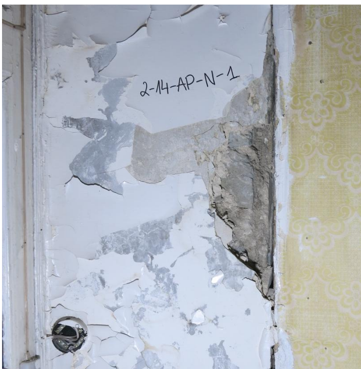
Foto 298. SONDAAŽ 2-14-AP-N-1 Põhjaseina akna idapoolsel aknapalendil on näha vanemat krohvikihiti ja esimese kihi hallikasbeeži lubi-/ liimvärvi, mis on olemas ka ruumis 2-13.
