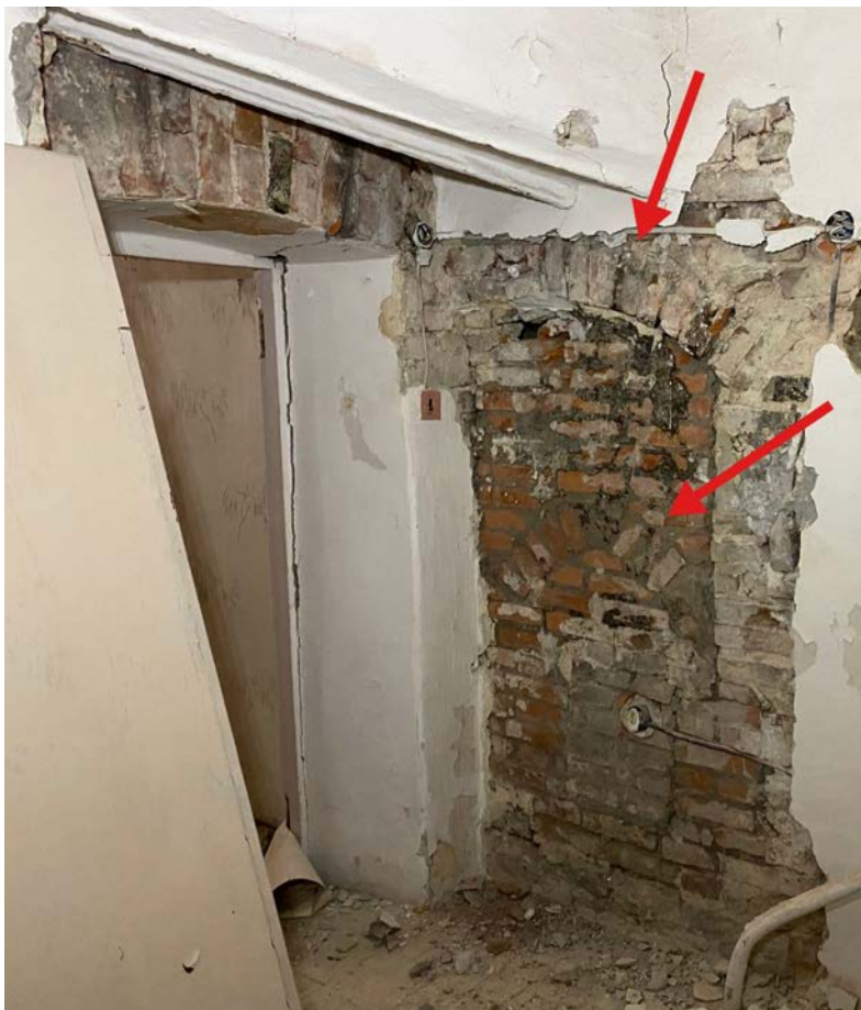
Foto 192. Ruumi kirdenurk, kus on uus ukseava ja uuem seinalõik. Nooltega on märgistatud kaks sillust.
