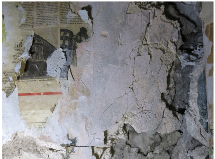
Foto 310-311. SONDAAŽ 2-16-S-W-3 – sondaaž lääneseina paremas servas, keskosas. 1843. aasta krohvil on säilinud valge ja roosa lubi-/liimvärv, ajaleht ja üks kiht tapeeti.
