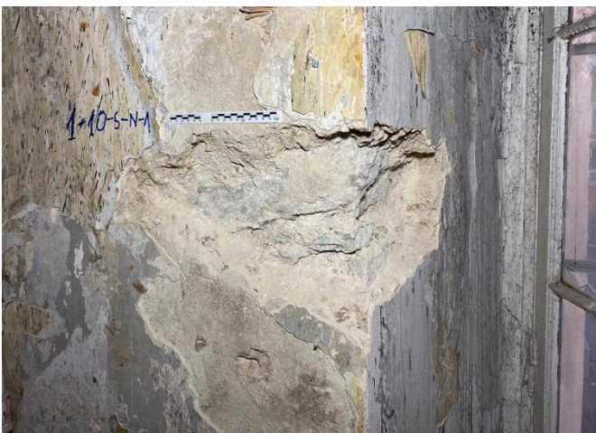
Foto 169. SONDAAŽ 1-10-S-N-1 – Krohvi-sondaaž aknapalel, kus on näha ruumi ehitusmaterjal (paas) ning kaks krohvikihiti. Esimesel krohvikihil eristatavad viimistlused puuduvad, teisel on säilinud ainult paar kihti monokroomset värvi.
