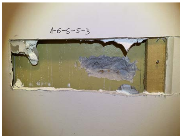
Foto 117. SONDAAZ 1-6-S-S-3 asub ruumi lõunaseina läänepoolsel osal ning näitab telliste ja kõrge tsemendisisaldusega krohviga kinni müüritud ava, mis on viinud ruumi 1-8.
