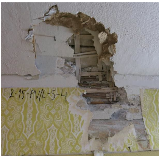
Foto 306. SONDAAZ 2-15-PV/L-S-4 – Sondaaž lõunaseina peegelvõlvil. Laudisel on näha alumises kihis roogu ning selle peal laastumatti. Viimase kihina on lagi kaetud masoniitplaadiga ja värvitud valgeks.
