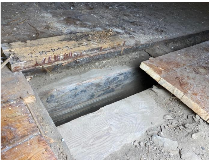
Foto 265. SONDAAZ 2-10-P-S-2 põranda-sondaaz, milles paljandub baroksete akantusmaalingutega tala. Suure tõenäosusega on ka sel puhul tegemist taaskasutusega, nii nagu ka akna- ja ukseasilluste puhul.
