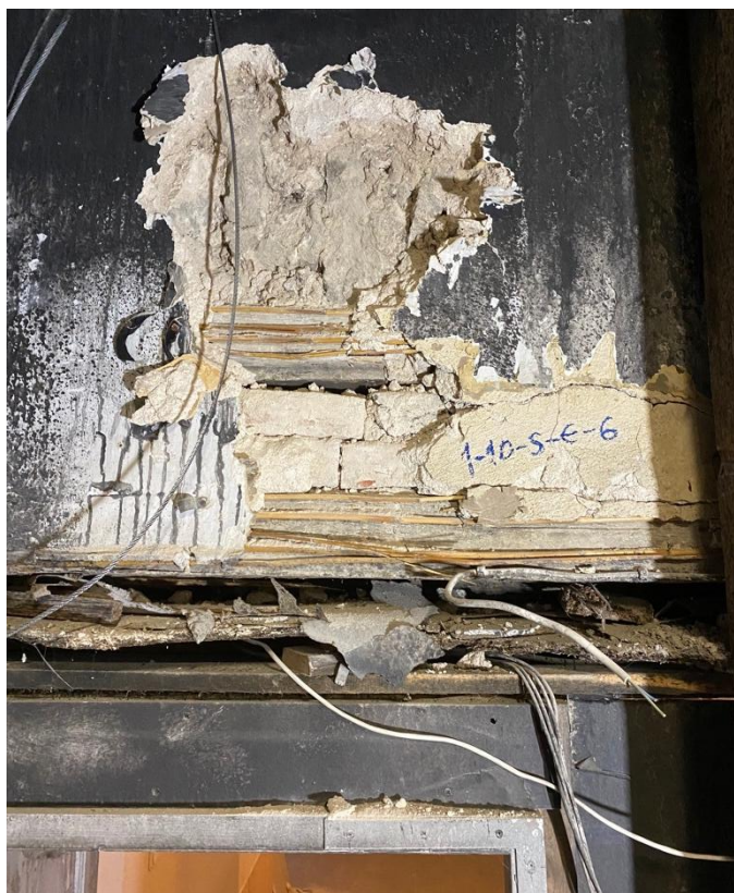
Foto 175. SONDAAZ 1-10-S-E-6 Krohvi-sondaaz ruumi idaseina ukseava kohal, kus on näha kaks roomatiga kaetud puitsillust. Ava on tõenäoliselt tekkinud pärast peafassaadi ukse asukoha nihutamist (u 1900), kui kogu avade telg nihutati lõuna suunas. Selgelt on näha, et sillus on ehitatud kättesaadavatest materjali-dest ning üsna rohmakalt.
