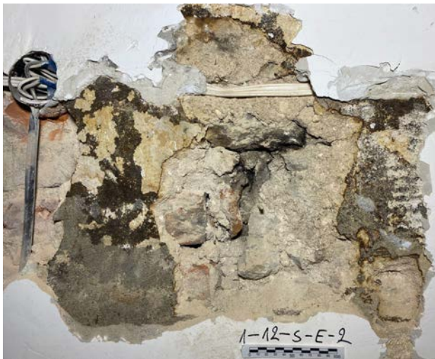
Foto 190. SONDAAZ 1-11-S-E-2 Sondaaž asub samuti ruumi idaseinas, kuid eelnevast sondaažist pisut põhja pool. Sellest seinast on millalgi osa maha lammutatud ning siis telliskividest jälle üles laotud. Sondaažil on näha pae ja tellise kokkupuute koht.
