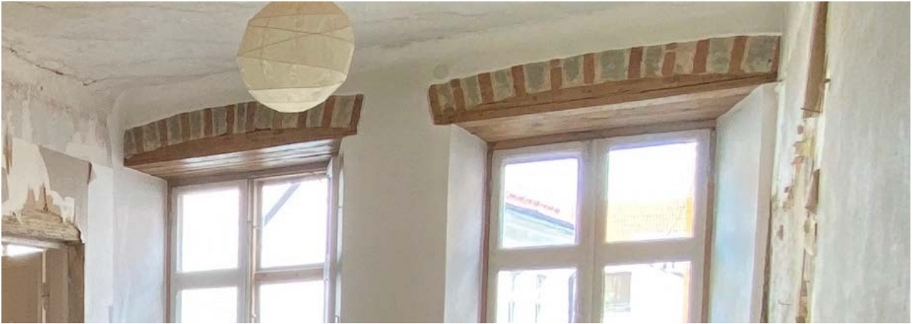
Foto 257. Hiljutise remondi käigus välja puhastatud aknasillused, kus on 1843. aastale iseloomulik kiviladu (vaheldub punane tellis ja paas) ning taaskasutatud varasemad (reeglina maalingutega) talad.
