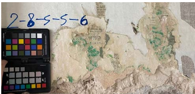
Foto 248. SONDAAZ 2-8-S-S-6 Hilisemad, 1843. aasta krohvil paiknevad viimistluskihid. Kõige alumine on arseenrohelise pigmendiga trükitud tapeet, mis paikneb saksakeelse gooti kirjas ajalehe peal.
