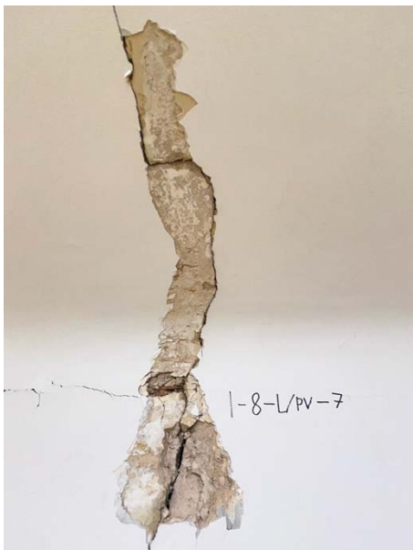
Foto 153. SONDAAŽ 1-8-L/PV-7 Täiendav sondaaž kaare keskosas, laes ja peegelvõlvil. Kaare võlvil leiti sarnaselt ülejäänud seintega eeldatav 1843. a. ehitusaegne krohv koos sellele iseloomuliku roomatiga. Märkimisväärseid viimistluskihte peegelvõlvil ega laes ei leitud.
