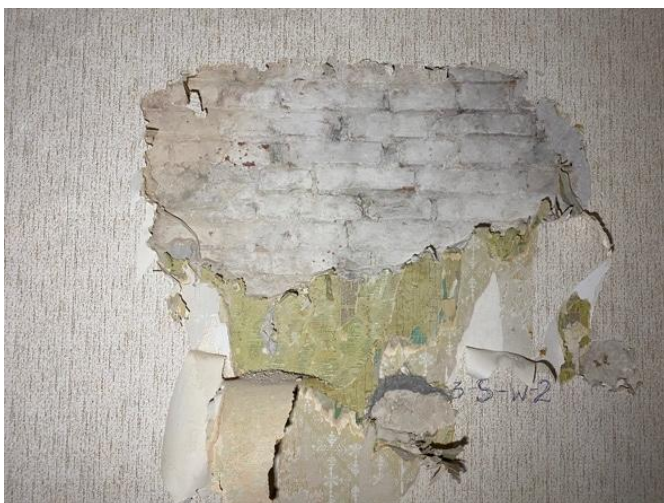
Foto 83. SONDAAŽ 1-3-S-W-2 – läänesein, suurem tsementkrohvi paranduskoht.
