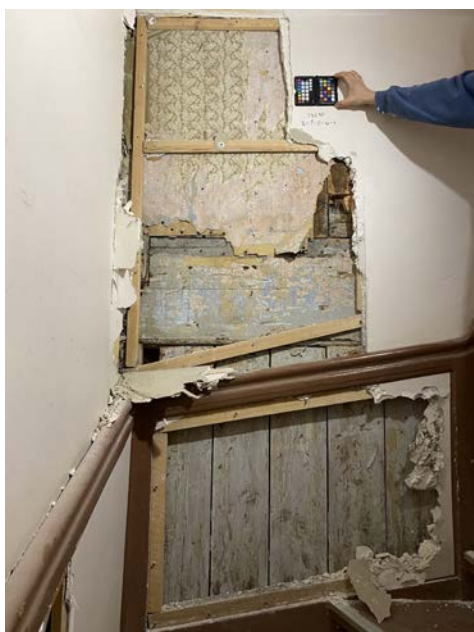
Foto 203. SONDAAŽ 2-1-S-W-1 asub trepiga seotud ja sellest läänepool asetseval kergseinal. Näha on seina konstruktsiooni, rullmustreid, tapeete ja nõukogude- aegset ajalehte tapeetide all. Kergsein on ehitatud kättejuhtuvast puitmaterjalist.
