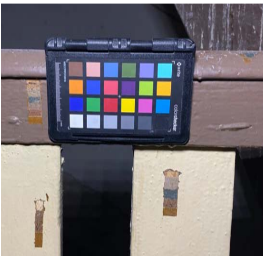
Foto 50. SONDAAŽ B-TREPP-1 asub ruumis 1-14 oleval balustraadil. Sondeerides tuvastati seitse kihti värvi. Üks "baluster" on hiljem välja vahetatud, seega on sellel vähem värvikihte (täpsemalt vaata sondaažikaardilt B-TREPP-1 ).
