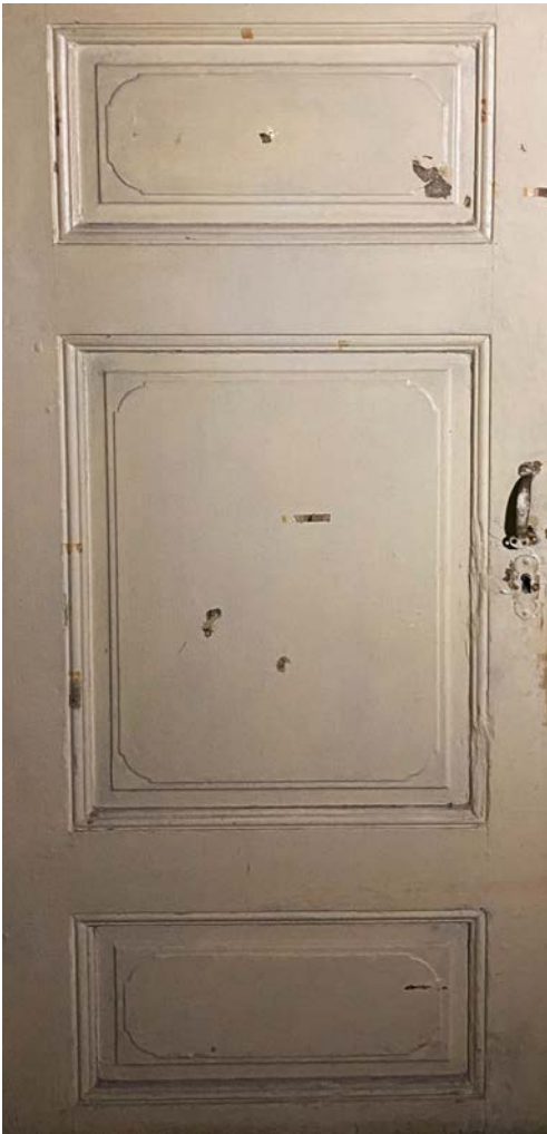
Foto 34. Näide baroksest taaskasutatud uksest (ruum 2-17).
