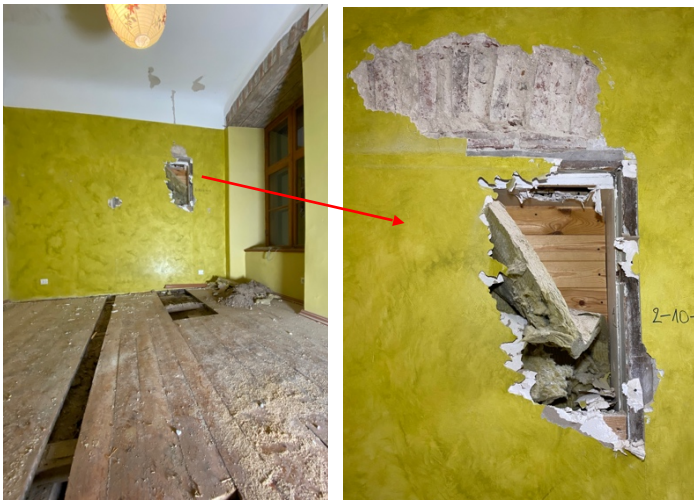
Foto 264. SONDAAZ 2-10-S-N-1 anfilaadisel teljel paiknev kinnimüüritud ukseava põhjaseinas. Silluskaar on laotud pikkadest kitsastest tellistest erinevalt aknasillusest, kus tellis vaheldub paekiviga.
