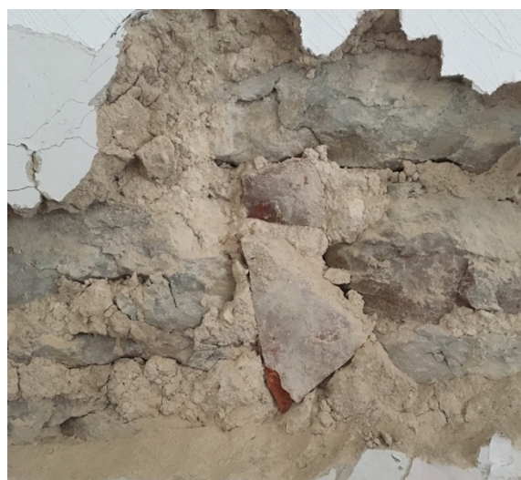
Foto 16-17. 1843. a renoveerimisele on iseloomulik seinapinna tasandamiseks varasemate katusekivide kasutus krohvi sees. Näited ruumidest 2-8 ja 2-3, aga samasugust materjalikasutust võib märgata kõikjal, sh ka B-korpuse ruumides.
