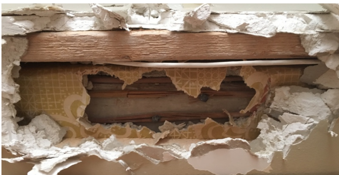
Foto 211. SONDAAŽ 2-2-US-W-3 – Krohvi-sondaaž läänepoolsel uksesillusel, kus on näha vana (taaskasutatud?) tala ning sepanaeltega kinnitatud roomatti.
