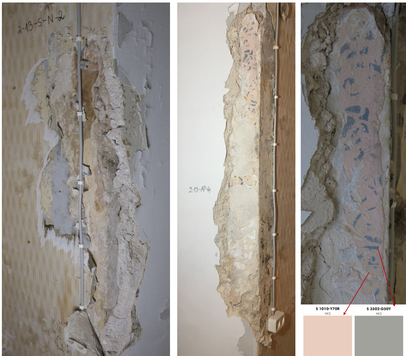
Foto 290. Krohvitükid ruumidest 2-13, 2-14 ja 2-15. Rohelises raamistuses krohvid kuuluvad esimesse kihistusse ja on võetud aknapaledelt (krohv 1-3) ja ruumi 2-15 idaseinalt, pajuviitstega alusmati pealt. Punases raamistuses krohvid on ruumi 2-13 ukseava kinnimüürimise krohv (krohv 5) ja ruumi 2-11 viimistluskrohv, mis on kantud laastumatile (krohv 6).
