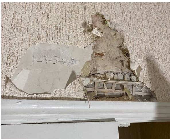
Foto 86. SONDAAŽ 1-3-S-W-5 krohvisondaaž lääneseinas. Praegu seina lõunapoolses kolmandikus paiknev seinakapp oli algsetelt uks. Sondaažis on näha ukse silluse asukohta. Kivisillus on laotud vaheldumisi pae- ja telliskividest.
