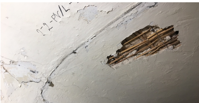
Foto 212. SONDAAŽ 2-2-PV/L-2 – Krohvi-sondaaž laes, kus on näha roomatti ning 19. sajandi keskpaiga krohvi.
