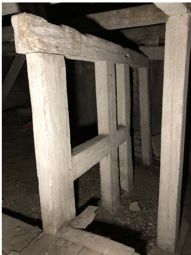
Foto 322-323. Ruumide 2-18 ja 2-19 vahvärkseina ülemine osa, mis on nähtaval B-hoone pööningul.
