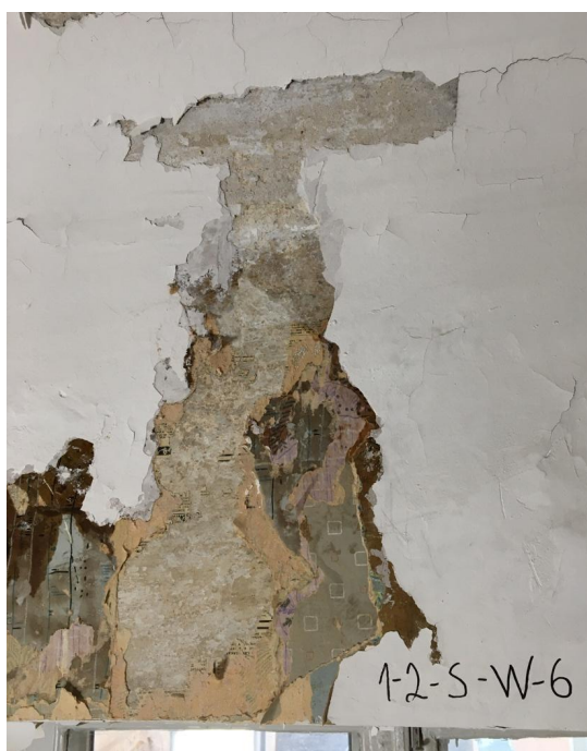
Foto 78. SONDAAŽ 1-2-S-W-6 Lääneseina vasakpoolse akna kohal seinal ja peegelvõlvil on fragmentselt säilinud valge ja heledam roheline lubi-/ liimvärvi kiht, mis on iseloomulikud ruumide 1-2 ja 1-4 ülemistele tsoonidele. Hilisemate laevärvide all, mis ulatusid ka peegelvõlvile ja seinte ülemise osa peale on säilinud 6 kihti nõukogudeaegseid tapeete.
