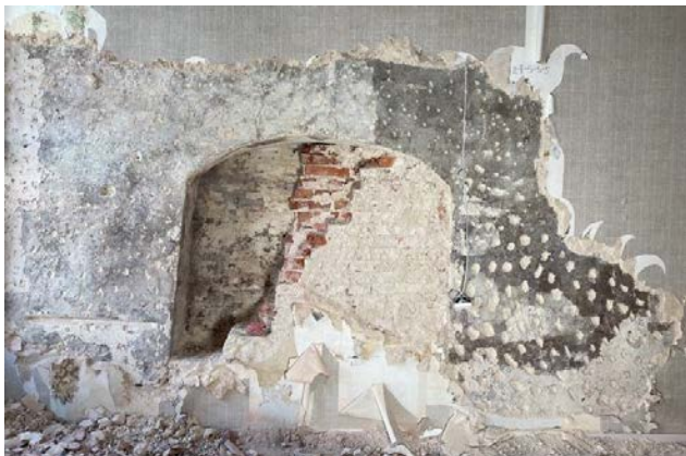
Foto 247. SONDAAZ 2-8-S-S-5 – Lõunaehk välisseinas leitud idapoolne nišš ning varasem krohv, millel on korduvad (u 10) viimistluskihid. Nišš näib olevat kinni müüritud seoses 1843. aasta ümberehitusega, millele viitab müüritise krohvi iseloom.
