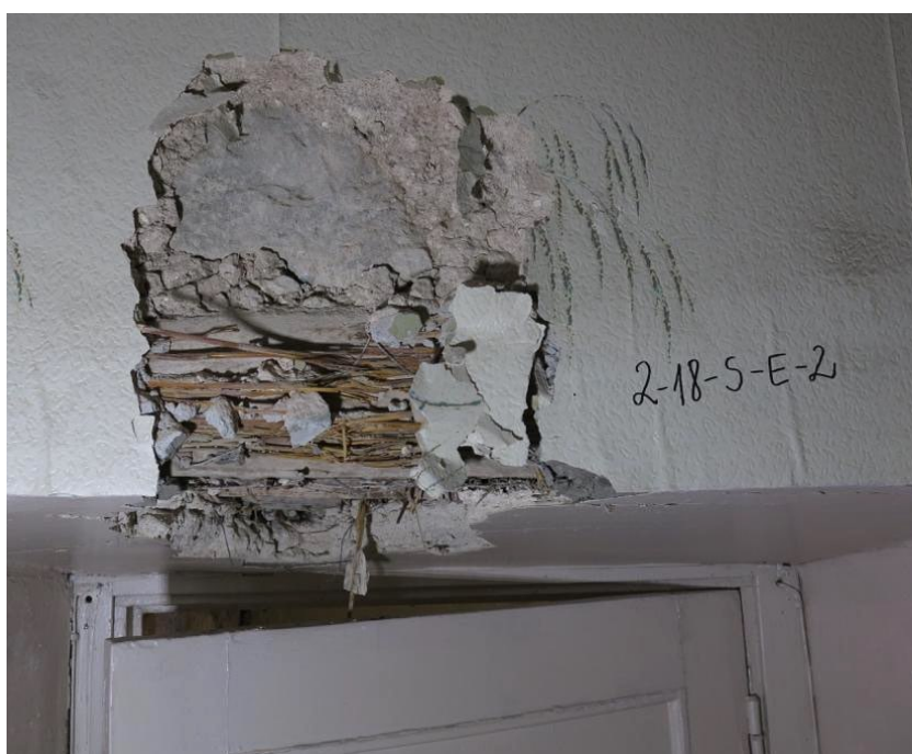
Foto 322-323. Ruumide 2-18 ja 2-19 vahvärkseina ülemine osa, mis on nähtaval B-hoone pööningul.
