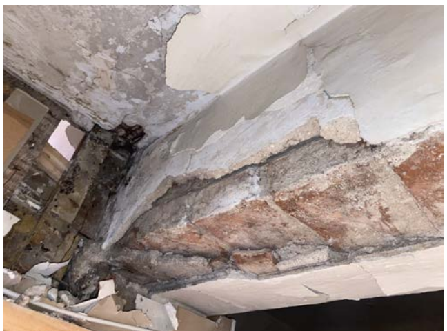
Foto 61-62. SONDAAZ 1-1-L-5 asub trepist lääne pool ruumi 1-1 laes. Plankudel on näha jälgi roomatist, mis erinevalt hoone 19. keskpaigu ümberehitamisega seonduvast on kinnitatud konksudega, mitte harilike sepanaeltega. Taolist roomatti on näha ka B-hoone tagumise trepikoja vahekorrusel. Külgnevat seinajuppi on alt eemaldatud, sealjuures seda toestamata, va. tsementkrohviga.
