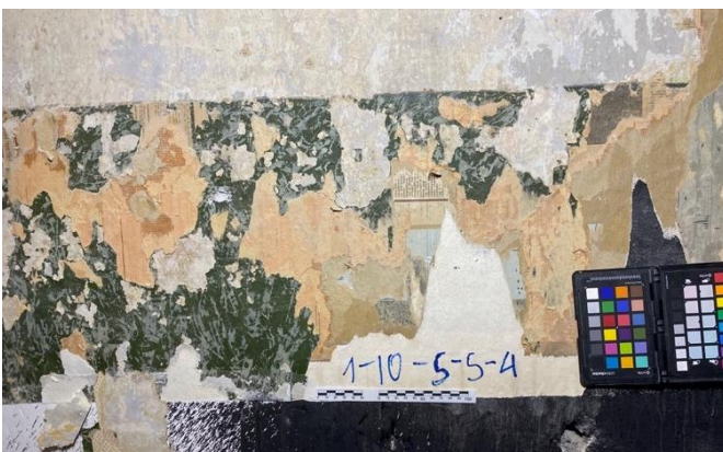
Foto 170. SONDAAŽ 1-10-S-S-4 Viimistluskihid ruumi lõunaseinal. Tapeedikihid (pigem 20.saj) on ainult lambriitsoonis, seina põhiosas piirdub säilinud viimistlus vaid mõne monokroomse kihiga.
