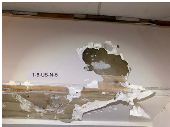
Foto 119. SONDAAZ 1-6-US-N-5 asub ruumi 1-7 viiva uke kohal ning sellest on näha, et tegemist on hilisema avaga, sellele viitab uuem sillus ja kõrge tsemendisisaldusega krohv silluse kohal.
