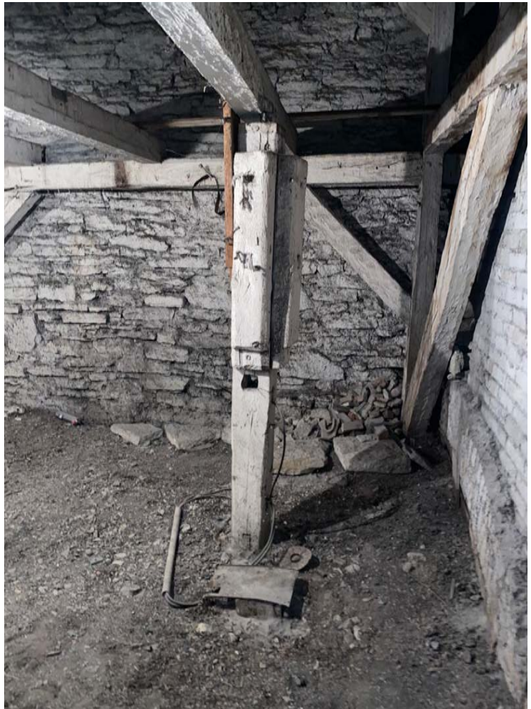
Foto 35. Lastimissüsteemi püstpöör B-hoone pööningul..
