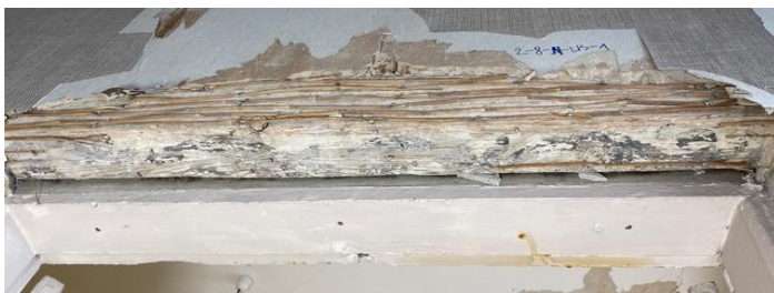
Foto 241. SONDAAŽ 2-8-US-N-1 ukse sillus põhjaseinas. Silluses on taaskasutatud barokset akantusmaalingutega tala.
