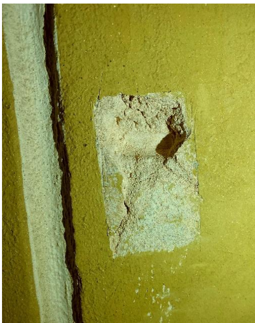
Foto 424. SONDAAŽ F-3 . Silluse imitatsioonil ei olnud originaalkrohvi peal täiendavat krohvikihiti. Siingi ei leitud peale lubivalge mingeid täiendavaid viimistluskihte. Originaalkrohvi struktuur on analoogne hoone sees leitud eeldatavale 1843. aasta krohvile.
