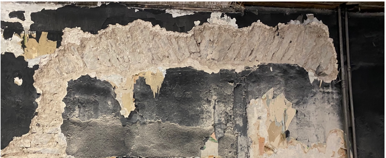
Foto 181. Pisut rohmakalt laotud kergenduskaar ruumi lõunaseinas.
