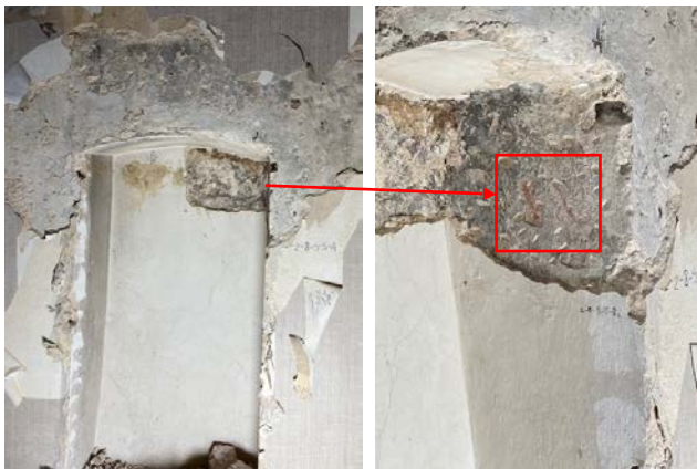
Foto 245-246. SONDAAZ 2-8-S-S-4 – Ruumi lõunasein on hoone välissein, kust tuvastati kaks kinnimüüritud nišši ning terve seina ulatuses varasem (1843. aasta eelne) krohv. Läänepoolse niši parel on kõige alumises kihis säilinud punased maalingufragmendid. Nišš on kinni müüritud 20. sajandil, millele viitab täitetellise kuju ning 1843. aasta krohvil olev viimistluskihtide arv (2 kihti)
