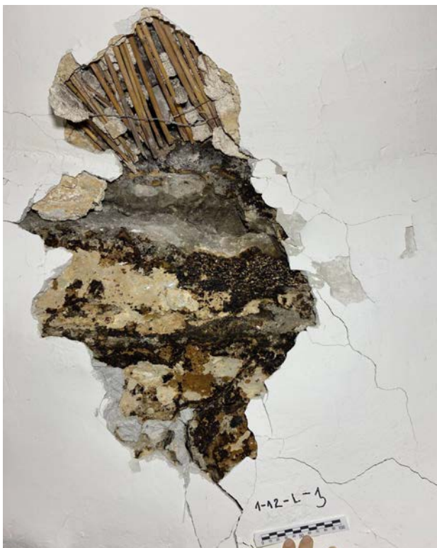
Foto 191. SONDAAZ 1-12-L-3 Seinasondaaz asub ruumi kagunurgas. Näha on tahmunud ja nõgist paekivi ladu, mis ülevalt koondub. Uus lagi on puidust ja krohvitud. Krohvimisel on kasutatud roomatti.
