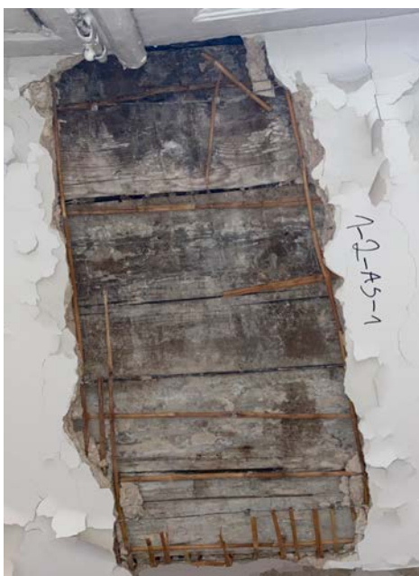
Foto 79-80. SONDAAŽ 1-2-AS-1 ja 1-2-AS-2 ruumi lääneseina akna-sillused.
