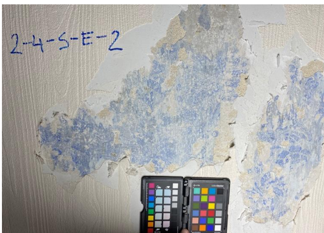
Foto 227. SONDAAŽ 2-4-S-E-2 1843. aasta krohvil olevate viimistluste sondaaž, kus esimeses kihis on üle kogu seinapinna kulgev trafaretiga maalitud ornament. Värvitoonid:
