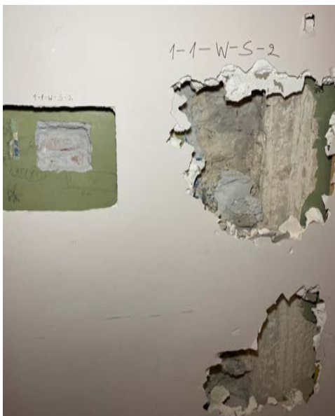
Foto 58. SONDAAŽ 1-1-W-S-2 asub ruumi lääneseinal. Tegemist on päekivist ehitatud seinaga, milles asetsev ukseava on hiljem telliste ning suurema tsemendisisaldusega mördiga kinni müüritud. Seinal on 5 viimistluskihti, mis on kõik õlivärvikihid. Kinnimüüritud ukseava kõrval on alumises kihis 1843. ümberehituse eelne krohvikiht, millesse on löödud täkkeid nakke parandamiseks. Selle peal on 1843. aastale omane krohvikiht.
