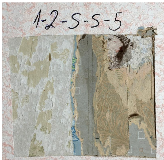
Foto 77. SONDAAŽ 1-2-S-S-5 Sondaaž lõunaseina keskosas. Tellisseinal on 1843. aasta lubikrohv, mida katavad valge ja hall lubi-/ liimvärvi ning kokku 6 kihti tapeeti.
