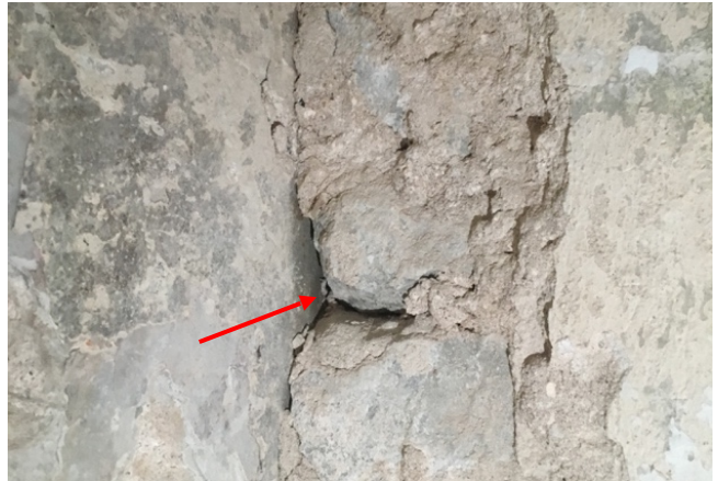
Foto 14. Ruumi 1-3 kirdenurk, kus on kõige selgemalt näha, et esifassaad läheb varasema viimistlusega põhjaseina peale.
