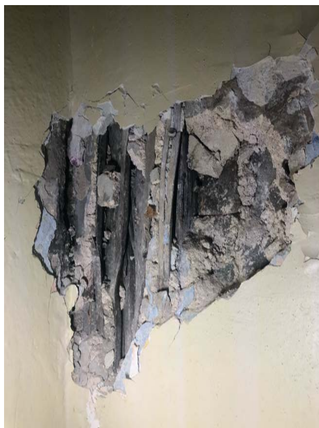
Foto 403-404. Ruum 1-5 lääneseinast leitud puitpost
