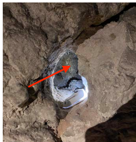
Foto 380. Kinnimüüritud avast VVA-1 paistab varasem krohvitud sein.
