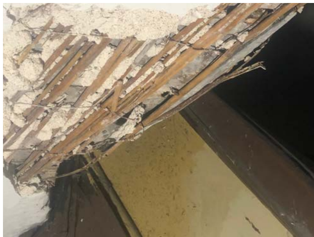
Foto 52-53. Fotod vahekorrusest ja lähivaade lae krohvist ning krohviarmeeringust.
