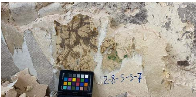
Foto 249. SONDAAZ 2-8-S-S-7 Hilisemad, 1843. aasta krohvil paiknevad viimistluskihid. Arseenrohelise tapeedi peal paiknev pruunides toonides lehemustriga tapeet.
