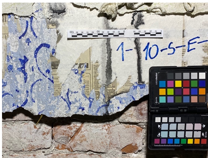
Foto 176-177. SONDAAZ 1-10-S-E-7 – Krohvisondaaž ruumi loodenurgas, mis avati juba 1998. a uuringute käigus 50 ning mida antud uuringute raames laiendati. Paljandub kinnimüüritud ava, mis oli ilmselt esifassaadi lõunapoolse peaukse nihutamiseni aastal 1900 ruumi peasissepääs. Siis nihutati kogu selle tiiva uksi, ei säilitada sissepääsude teljelisus.
