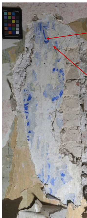
Foto 73-74. SONDAAŽ 1-2-S-E-3 – Sondaaž idaseina keskosas, uksest paremal. Müüritises on näha ka majaplaanile märgitud, kuid nõukogudeaegsete renoveerimistöödega kinni müüritud ukseava (vt ka ruum 1-3). Osaliselt on säilinud 1843. aasta krohv, millel on näha valget kruntvärvi ja selle peal hilisemat tumesinist piiramata pinnana teostatud trafarettmustrit helehallil taustal. Mustri peal on säilinud ca 2 kihti nõukogudeaegset ja 1 kiht hilisemat tapeeti.
