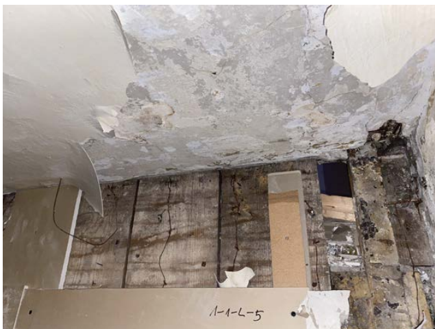
Foto 61-62. SONDAAZ 1-1-L-5 asub trepist lääne pool ruumi 1-1 laes. Plankudel on näha jälgi roomatist, mis erinevalt hoone 19. keskpaigu ümberehitamisega seonduvast on kinnitatud konksudega, mitte harilike sepanaeltega. Taolist roomatti on näha ka B-hoone tagumise trepikoja vahekorrusel. Külgnevat seinajuppi on alt eemaldatud, sealjuures seda toestamata, va. tsementkrohviga.
