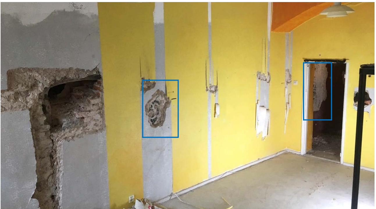
Foto 6-7. Hoone lõunaseina mõlemal korrusel ( ruum 2-8 üleval ja ruum 1-8 all ) leidub 1843 .aasta ümberehituse eelseid krohve, viimistlusi, maalinguid, ehitustarindeid jmt. Punase noolega märgitud ruumi 2-8 horisontaalne süvis, sinise kasti ja joonega varaseimad maalingud ruumides 1-8, 1-9 ja 2-8
