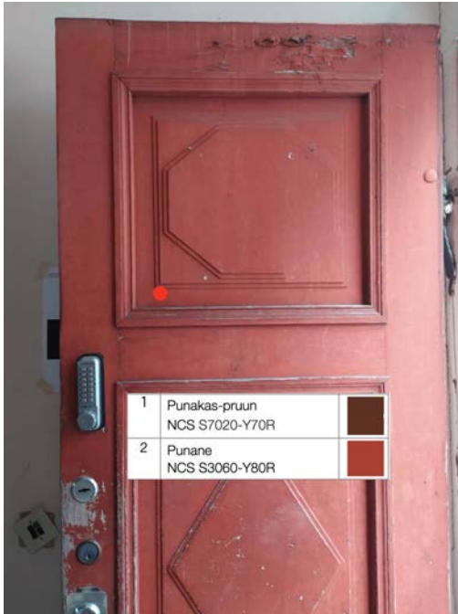
Foto 66. SONDAAŽ VU-4-1 asub välisukse välisküljel, ülemise tahvli nurgal. Sondaažiga on tuvastatud kaks värvikihti, punakas-pruun ja punane (lähemalt vt sondaažikaardilt VU-4-1 ).
