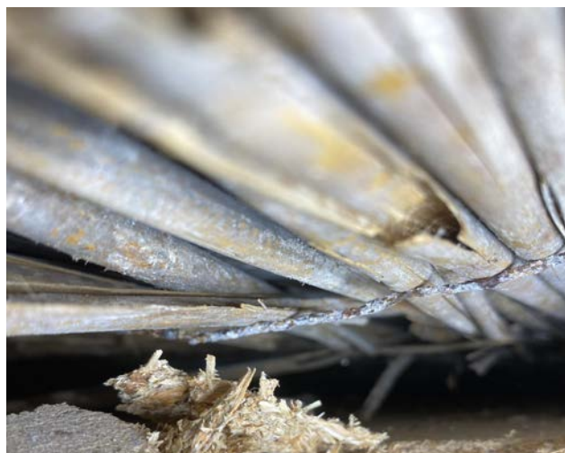
Foto 196-197. SONDAAZ 1-13-S/L-4 asub ruumi lääneseina põhjapoolses nurgas. Laes on näha traadiga kinnitatud roomatti. Ruumi läänesein on laotud tellistest ning krohvitud lubikrohviga, seinal on mõned kihid heledat lubivärvi ning hilisem valge alküüdvärv.
