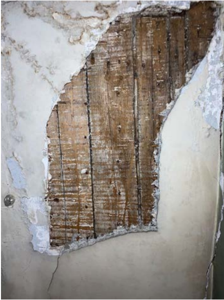
Foto 328. SONDAAZ 2-19-L-2 asub ruumi lae põhjapoolses ääres. Avangust on näha, et lage katva lubikrohvi all on olnud roomatt.
