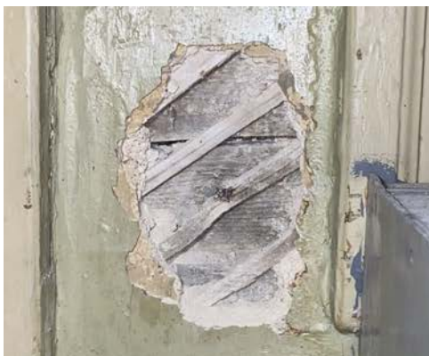
Foto 315. SONDAAŽ 2-17-S-W-2 Sondaaž paikneb ruumi lääneosas panipaika ja ruumi 2-17 eraldavas vaheseinas ning näitab puitkergseina, millel on naeltega kinnitatud kistud laastumatt ning see kaetud lubikrohvi ja värvikihtidega.
