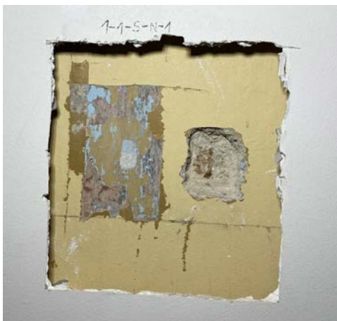
Foto 57. SONDAAŽ 1-1-S-N-1 asub ruumi põhjaseinal. Kipsplaadi taga asetsev tellissein on krohvitud 1843. aasta ümberehitusega seostatud krohviga ning viimistletud liim- ja õlivärvikihtidega. Seinalt leiti ka üks rullmustri kiht.
