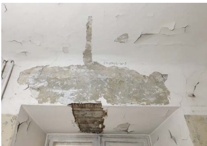
Foto 107. SONDAAŽ 1-4-S-PV-L-W-5 – sondaaž lääneseina akna sillusel, selle kohal, peegelvõlvil ja laes. Aknasilluseks on taaskasutatud varasema hoone talasid. 1843. aasta viimistluskihid on krohvil säilinud fragmentselt ja maalinguid ei leitud.
