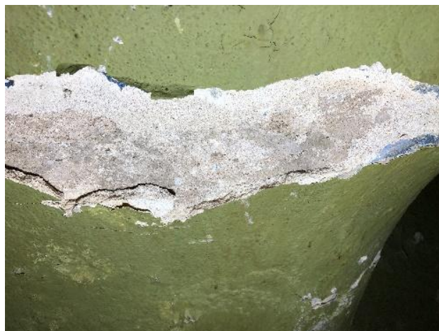
Foto 415-416. Lähivõtted krahvisondaažidest.
