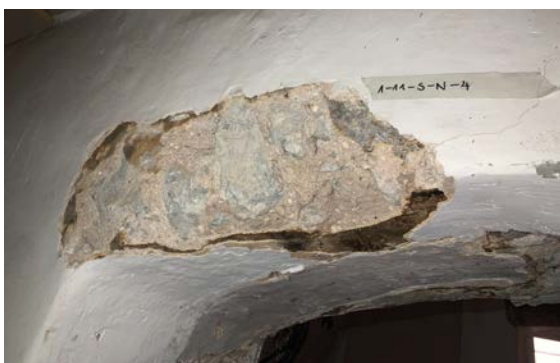
Foto 187. SONDAAZ 1-11-S-N-4 Seinasondaaz ruumide 1-11 ja 1-12 vahelises seinas ava kohal. Näha on, et ruume ühendava ava kohal on paekivist laotud sillus, mis viitab sellele, et ava on seintega samaaegne.
