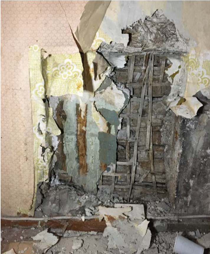
Foto 368. Sondaaž 3-10-S-N-2 Põhjaseina alumises tsoonis on laudisel laastumatt, selle peal TEP-plaat, tsementpahtel ja nõukogude-aegsed tapeedid.
