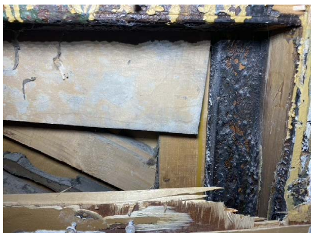
Foto 207-208. Põlengu jäljed trepipiirdel ja hilisem trepipiire.
