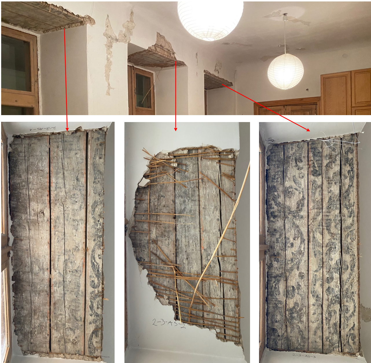
Foto 221-224. Ruumi 2-3 väga hästi säilinud barokkmaalingutega aknasillused
