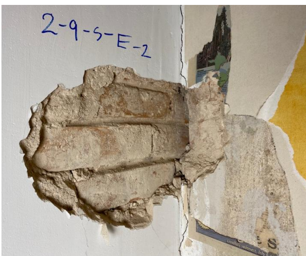
Foto 263. SONDAAŽ 2-9-S-E-2 – ruumi 2-9 ja 2-8 eraldava vahesine liitumine. Sein ei ole välis-seinaga seotud.
