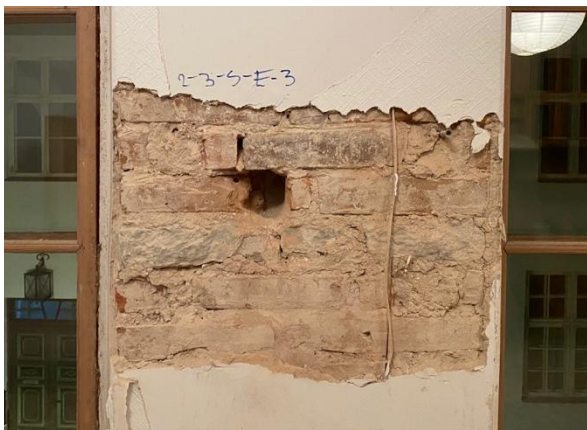
Foto 219. SONDAAZ 2-3-S-E-3 – akendevaheline krohvisondaaž, mis näitab, et akende asukohta ei ole muudetud, vaid kogu esifassaad on ümber ehitatud.
