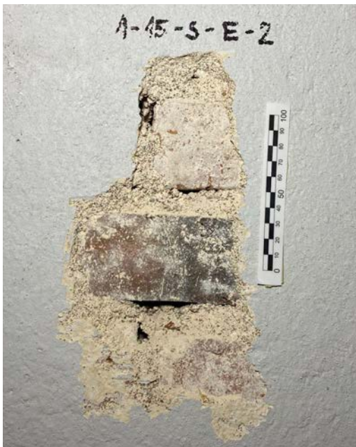
Foto 200. SONDAAŽ 1-15-S-E-2 Sondaaž asub ruumi lõunapoolses osas idaseinas. Nähtavasti on see sein, erinevalt ülejäänud seintest, laotud telliskividest ja on ilmselt hilisem.
